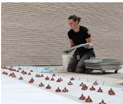
Plattorna hålls på plats med hjälp av distanser.
