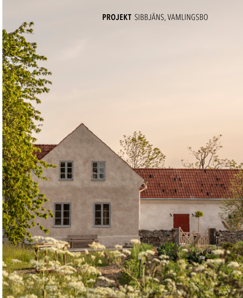
Gårdens byggnader i kalksten från 1800-talet har återställts för hand med traditionella gotländska metoder.
