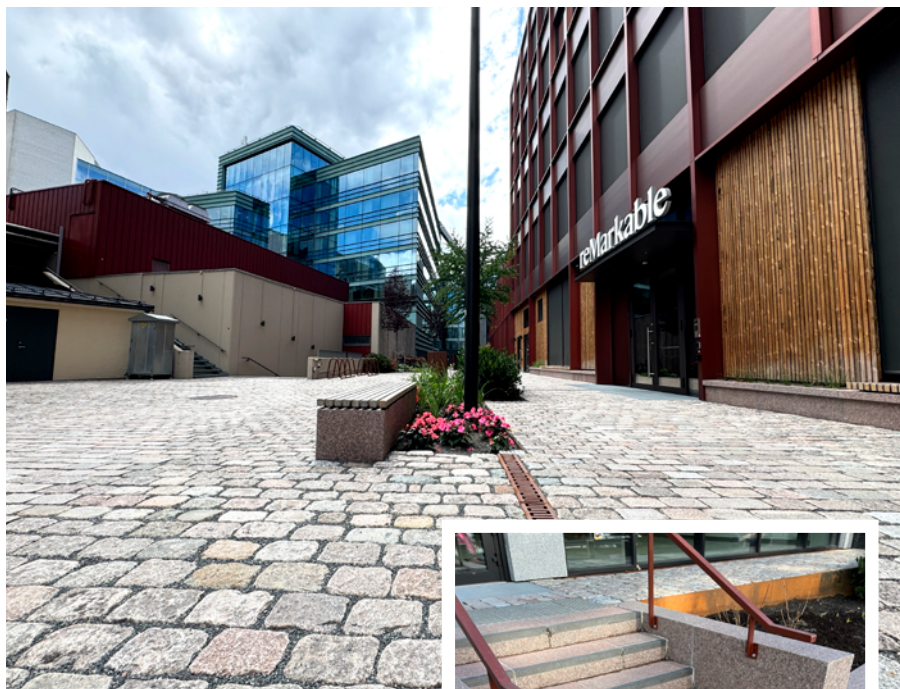
FOTO: SL STENLEGGNING
