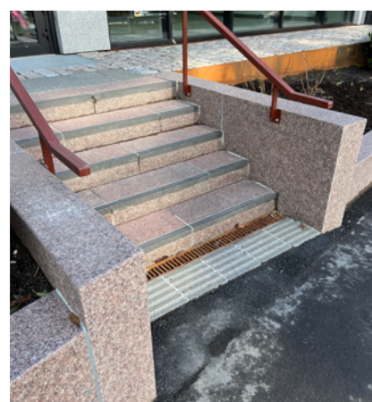
FOTO: SL STENLEGGNING
