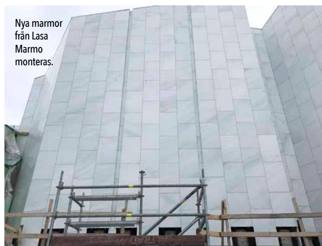
Buktande paneler i Carrara- marmor.
