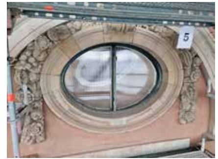
Festongerna av gotländsk sandsten konserveras, rengörs, brukslagas och konsolideras med kiselsyraester.
