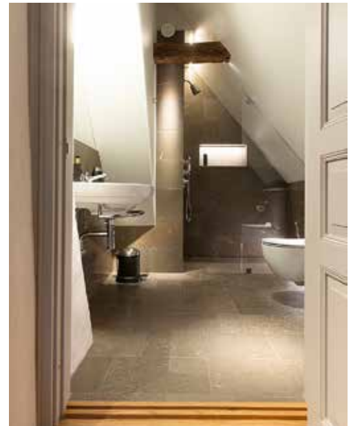
▲ Totalt har sju badrum och tre wc renoverats.
