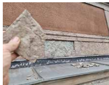
Typisk skadebild där ett lerklov skapar en svaghet i kalkstenen vilket så småningom leder till bortfall.
