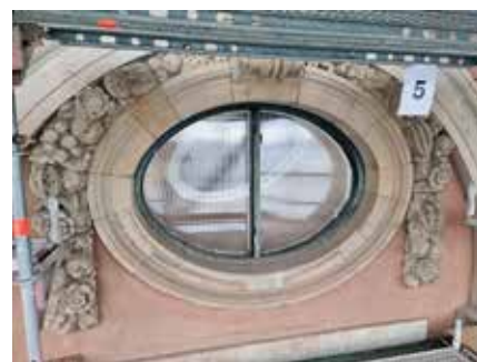
Festongerna av gotländsk sandsten konserveras, rengörs, brukslagas och konsolideras med kiselsyraester.
