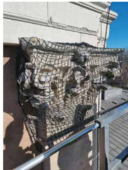
Ett antal partier och delar i fasaden är sedan lång tid nätade av säkerhetsskäl.
