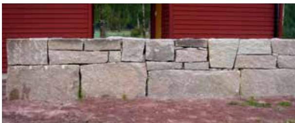
Fig 8.7 Kallmur av granitblock i rubbelförband
