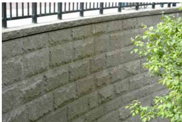
Fig 8.12 Svängd beklädnadsmur av grå granit med råköpp. Kvaderförband. Avtäckning av råkilad granit.
