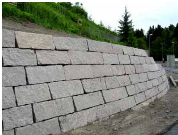
Fig 8.29 Kallmur av granitblock i vägsärning.
