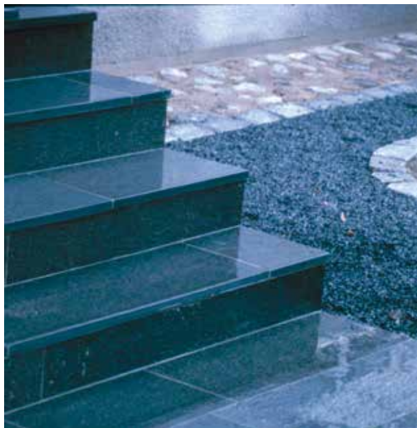
Fig 7.13 Beklädnadstrappa med steg av skiffer
