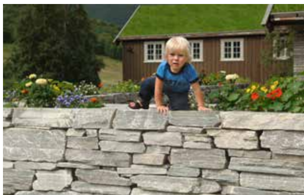
Fig 8.17 Kallmur av staplade skivor av skiffer
