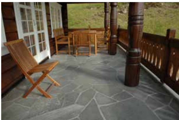
Fig 4.37 Altanbeläggning, skiffer med klovtyta.
