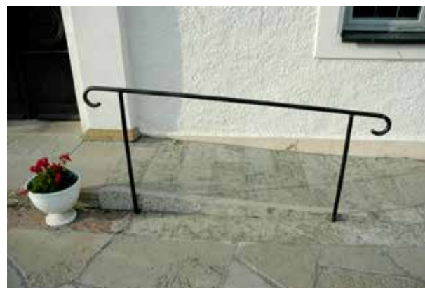
Fig 7.27 Låg ramp av kalksten för bättre tillgänglighet.
