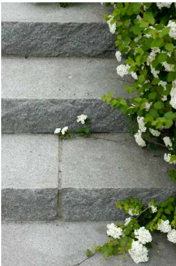
Fig 7.2 Blockstegstrappa av granit. Krysshämrad ovarsida och råkilad framsida.
