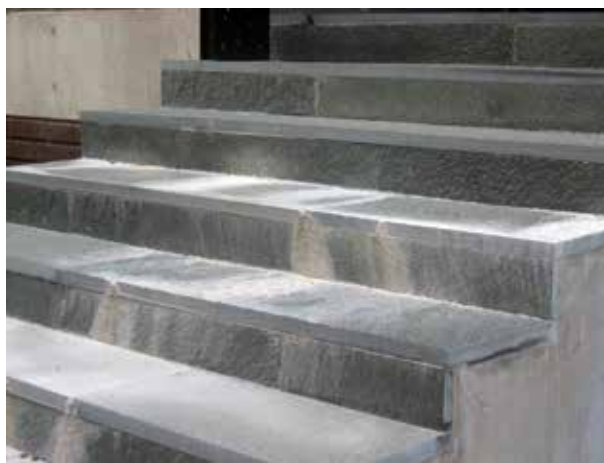
Fig 7.33 Misspyrdande salt- och kalkutfällningar, som är svåra att avlägsna. Sådana bildas när stora mängder vatten transporteras genom cementbruk.
