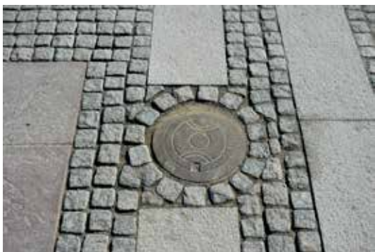
Fig 4.26 Gatsten runt brunnen ger god anpassning mot beläggningen.
