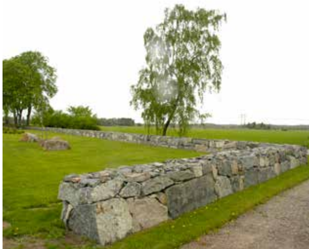
Fig 8.27 Kallmur av lokal sten, s k kyrkogårdsmur.
