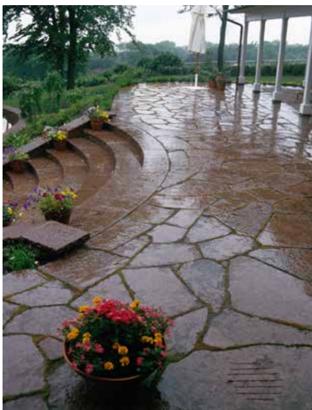
Fig 4.14 Altan med topphyvlad kalksten i oregelbundet mönster.
