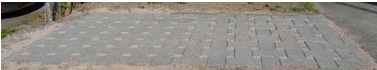
Fig 4.31 Dränerande parkeringsyta efter 4 års daglig användning
