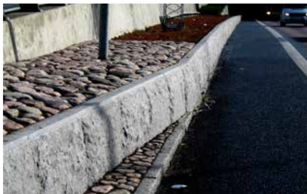
Fig 8.49 Blockstensmur av granit som stödmur och trafikbarriär
