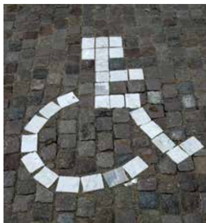
Fig 5.17 Gatsten med olika kulör kan användas för beständig markering i gatan.
