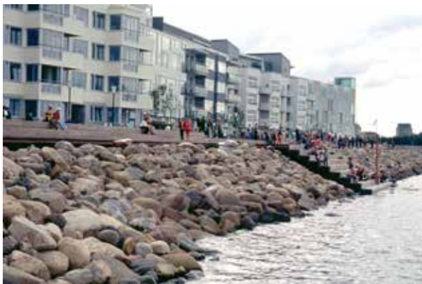
Fig 8.41 Släntbegräddning uppbyggd av runda fältstenar, som erosionsskydd mot havet.
