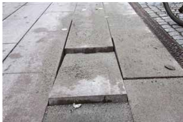
Fig 4.46 Stenmjöl har använts för fog och sättningslager. Den stora andelen finmaterial gör att vatten blir stående i fog och sättningslager. Vibrationer från biltrafiken pumpar bort finandelen ur fog och delvis ur sättningslager och plattorna lossnar.
