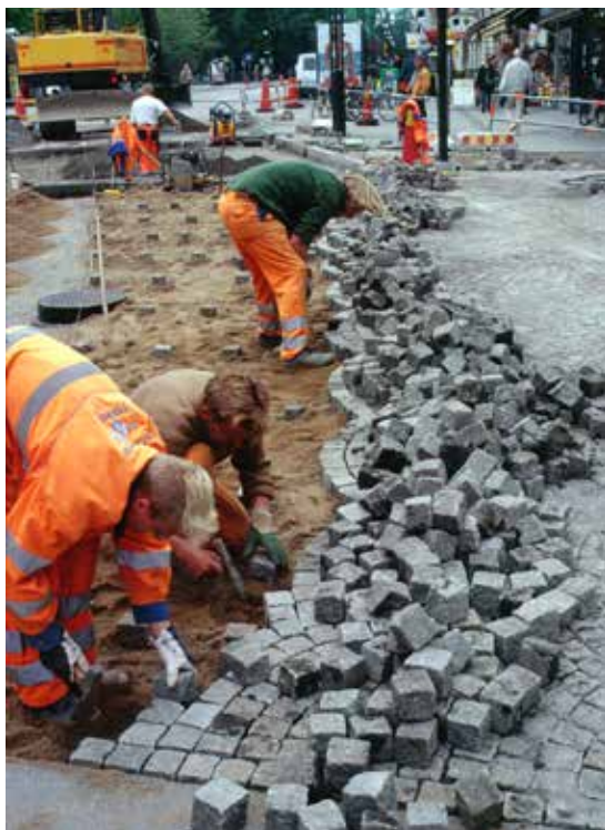
Fig 5.11 Bågsättning av smågatsten i obundet sättbruk/sand
