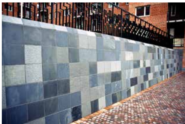
Fig 8.16 Beklädnadsmur. Skiffer med olika ytbearbetningar, klovyta, slipad och polerad. Kvadratiske plattor i rutmönster.
