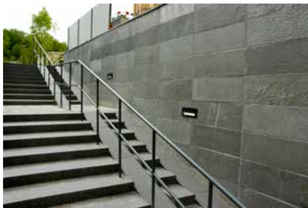
Fig 7.256 Barnvagnsramp integrerad i blockstegstrappa. Beklädnadsmur med skiffer.
