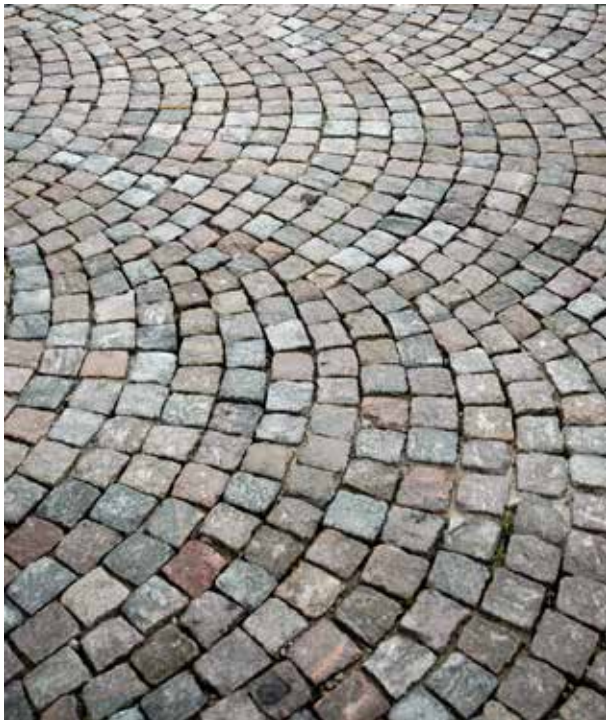
Fig 5.8 Bågsättning med smågatsten
