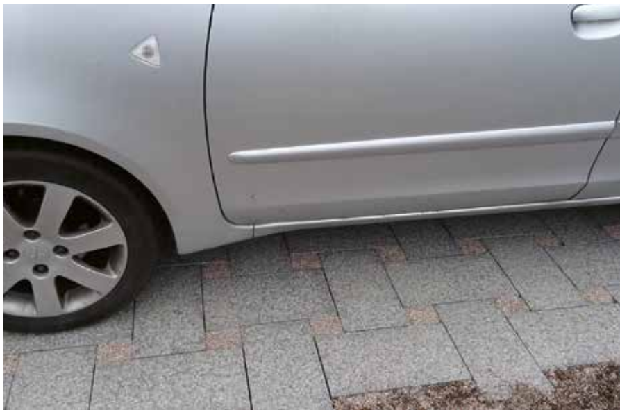
Exempel på rektangulära hållar lagda i förband som bildar dräneringsluckor.
