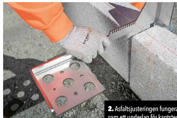
1. Locstone består av en front- och en bakplatta samt en länkarm som låser fast kantstenarna och förankrar den i körbanan.
