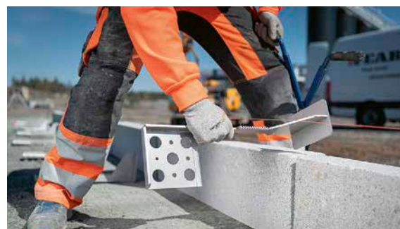
1. Locstone består av en front- och en bakplatta samt en länkarm som låser fast kantstenarna och förankrar den i körbanan.
