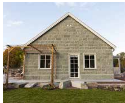
▲ Fasaden på totalt 130 kvadratmeter är monterad med luftspalt. Plattorna är fästa med kramlor.
