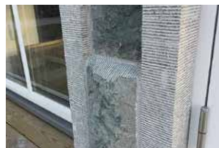
▲ I fönster- och dörrfattningar har Kaj sågat spår med vinkelslip och sedan bearbetat med mejsel.
