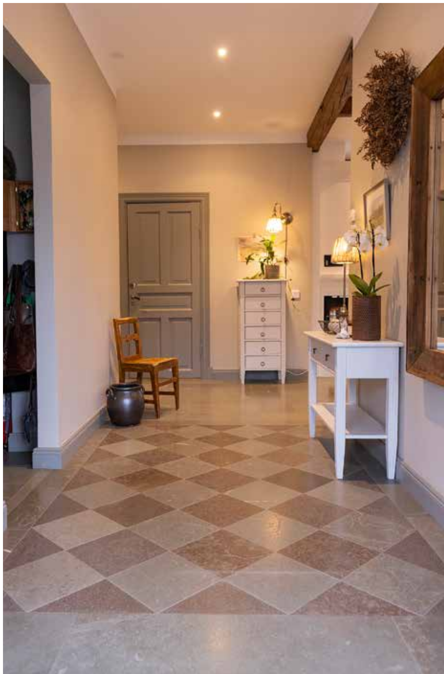
▲ Hallgolvet rutmönster är lagt med två nyanser av Borghamnskalksten.
