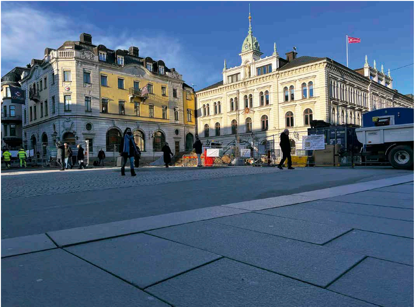
Flera av hållarna sågas om och får mindre mått så att de klarar tung belastning bättre.
