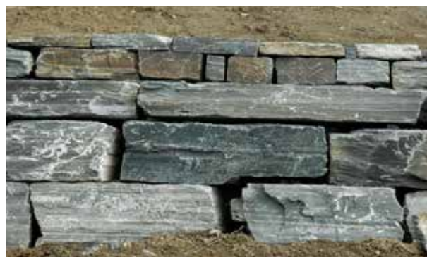
Fig 8.18 Kallmur av staplade skifferblock i kvaderförband.
