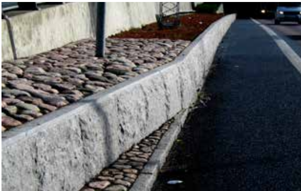
Fig 8.49 Blockstensmur av granit som stödmur och trafikbarriär
