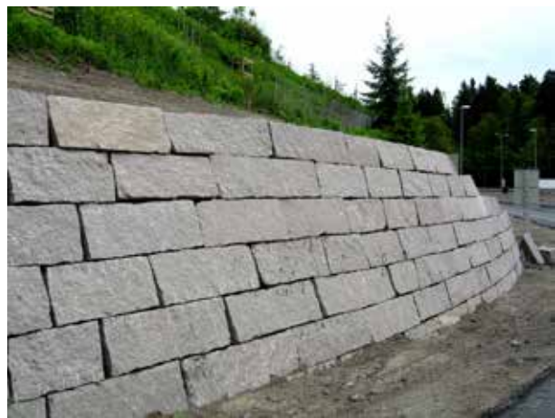
Fig 8.29 Kallmur av granitblock i vägsränning.
