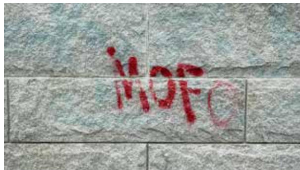
Fig 11.6 Klotter på granitmur
