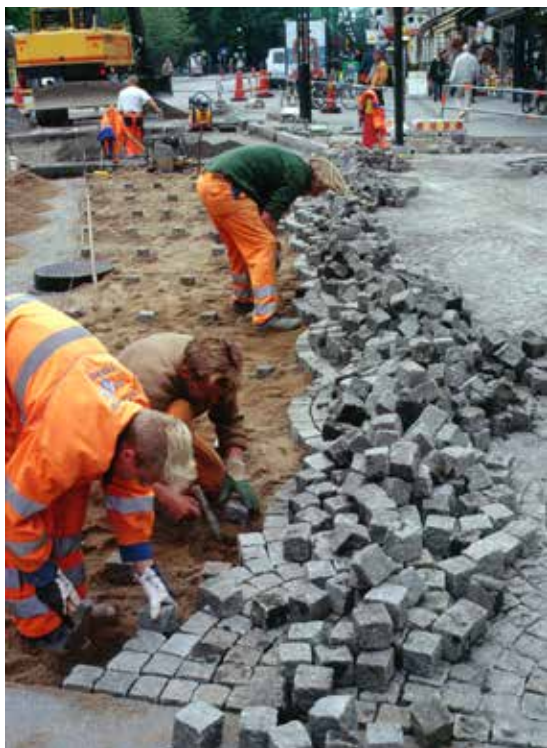
Fig 5.11 Bägsättning av smågatsten i obundet sättbruk/sand
