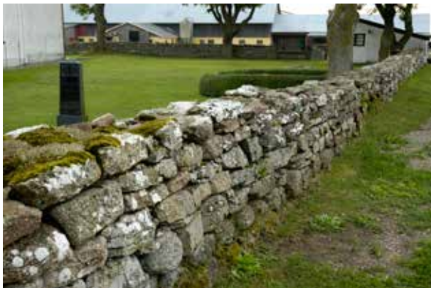
Fig 1.7 Gammal kallmur av kalksten, som åldras med behag
