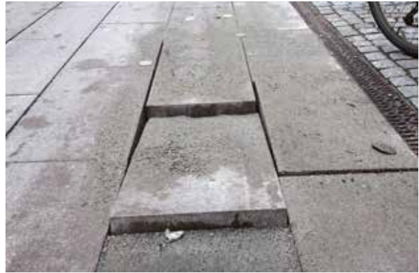
Fig 4.46 Stenmjöl har använts för fog och sättningslager. Den stora andelen finmaterial gör att vatten blir stående i fog och sättningslager. Vibrationer från biltrafiken pumpar bort finandelen ur fog och delvis ur sättningslagret och plattorna lossnar.
