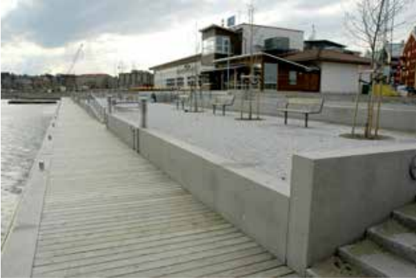
Fig 9.2 Kajläggning uppbyggd av granitblock med flammad yta.
