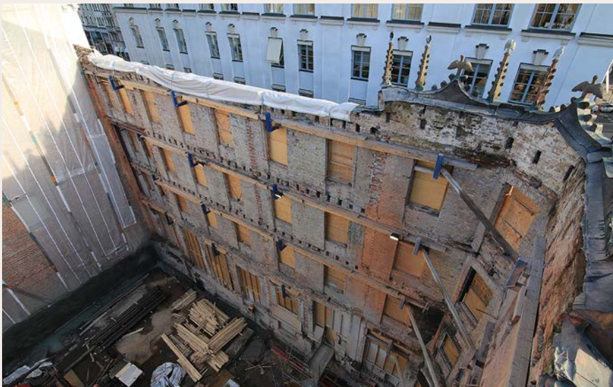
Av den gamla fastigheten finns endast murverket kvar, här stabiliserat av en kraftig stålkonstruktion och tjocka träbalkar. Nu pågår uppbyggnaden av en helt ny fastighet innanför murarna.
