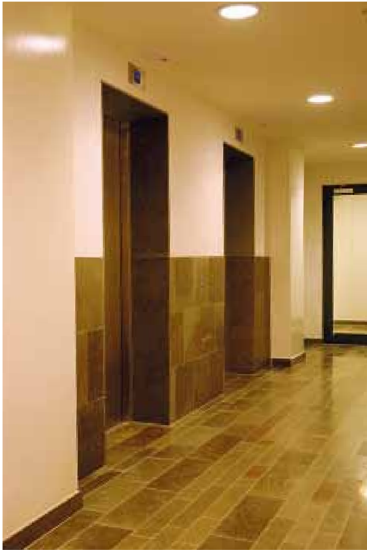
Flammig Ombergskalksten klär väggar och golv liksom hissfattning i detta rum. Stenens rika variation av rött, brunt och grått har gett en sober färgskala. Kvarteret Bocken, Stockholm, monterad i samband med tillbyggnad 2009.
