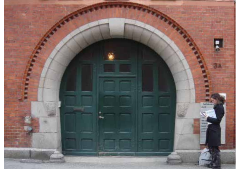
Kalkstensportal från 1900. Ornamentiken skyddas av runda påkörningsstenar.
