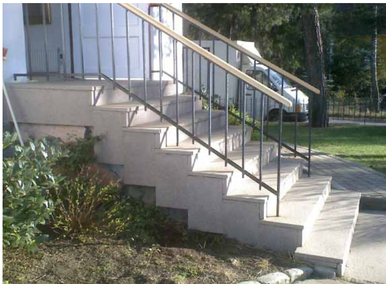
Trappa med beklädnadssten av krysshamrad, grå granit.
