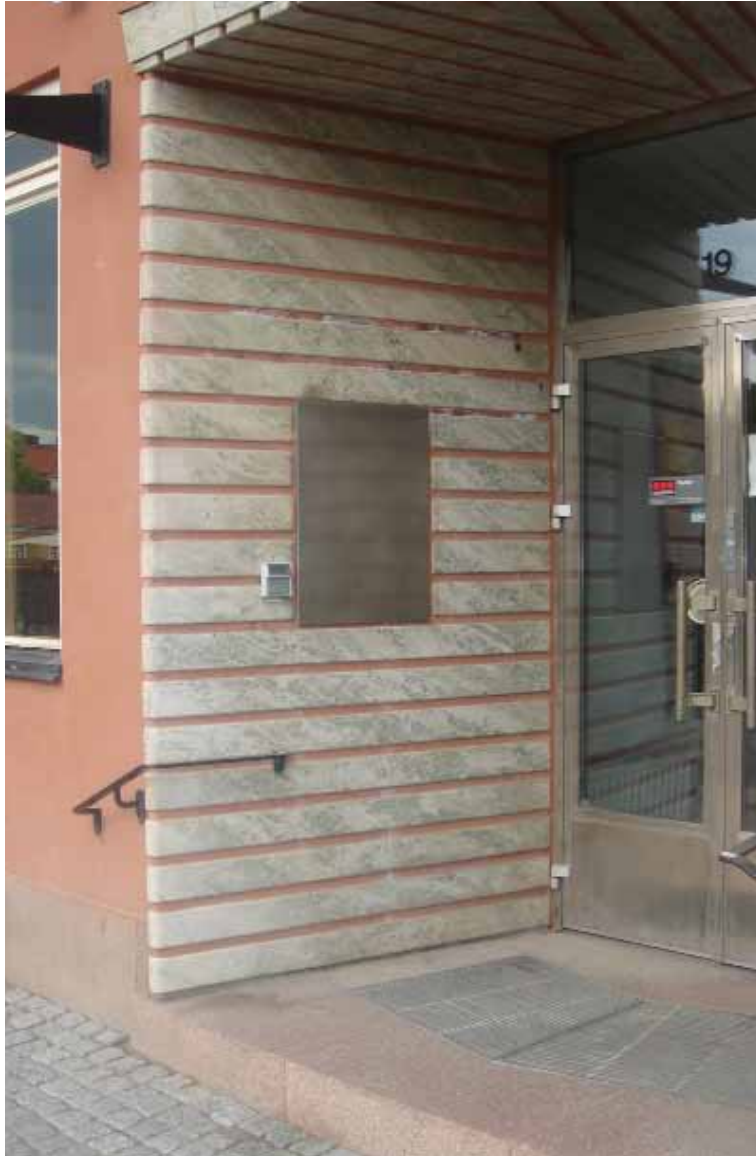
Entréer klädda med natursten välkomnar besökaren. Band av Ekebergsmarmor ger egenkaraktär åt entrépartiet och ett skydd för den putsade fasaden.
