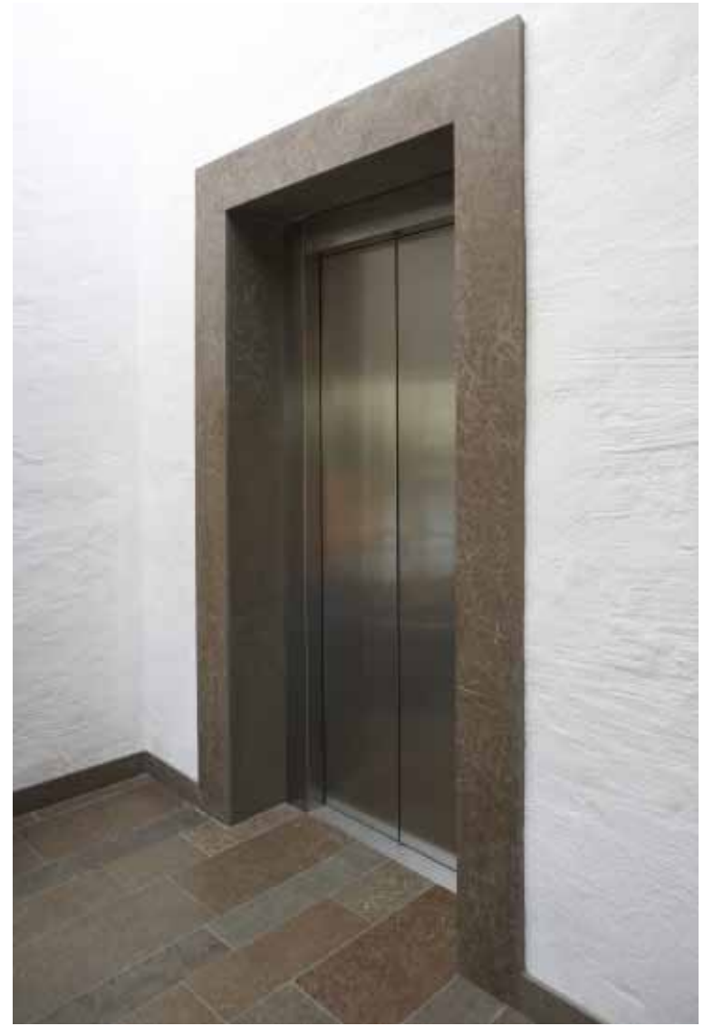
Odd Fellows hus i Uppsala har hissfattningar av slipad Ölandssten B1 och samma sten på golvet. Elegant och effektivt som skydd för murväggarna. Arkitekt är Wingårdhs.
