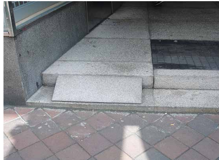
Krysshamrad granitramp är en billig lösning för rullväskor och barnvagnar.
