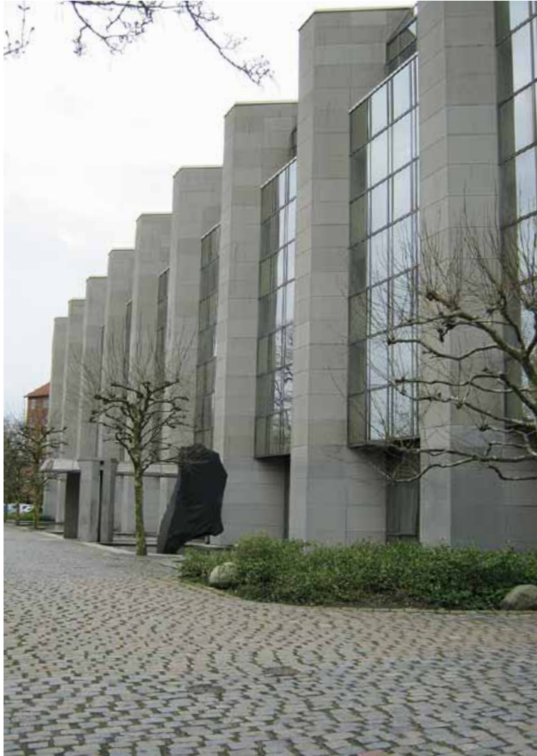
Cardohuset i Malmö, ritat av Sten Samuelssons arkitektkontor, och byggt 1987, har fasader av krysshämrad, grå Bohusgranit: Den storskaliga fasaden med sina »stenpyloner« döljer fem kontorsplan med 4800 m 2 kontorsyta. Stenen är 3 cm tjock och monterad på kontreforter av betong, Fasadplattorna på 80x120 cm väger ca 80 kg. Sammanlagd stenyta i fasad är 1750 m 2 .
