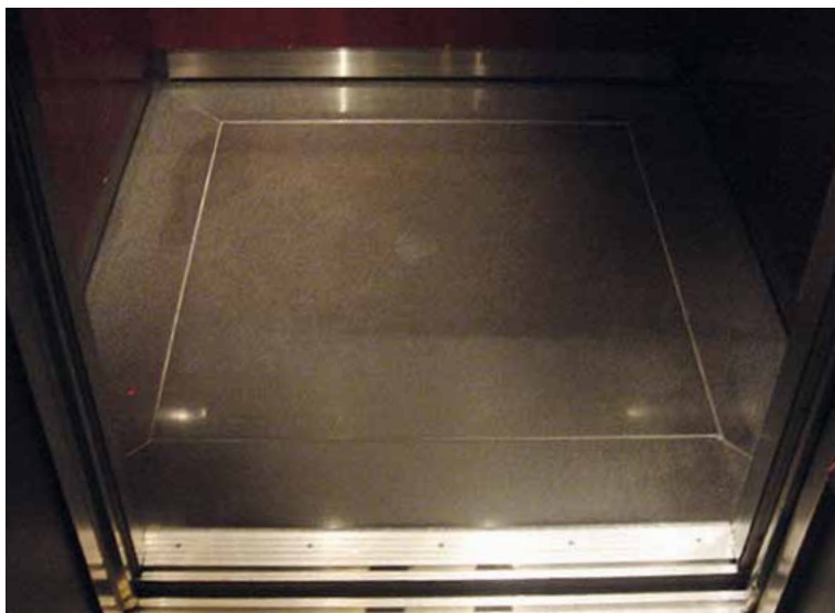
Hisskorgens golv av slipad diabas i form av en stor platta omgiven av en fris.
