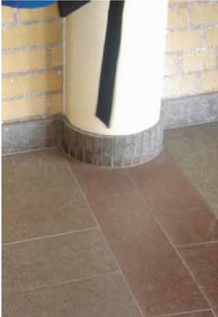
Sockel, 100 mm hög, av grå Ölandssten, G2, har anpassats till den bärande pelaren genom att delas upp i korta längder som fasetter. Golvet har fallande längder av samma sten, i grå G2, och med tvärgående markering av röd Ölandssten. Västra kyrkan i Hässleholm.
