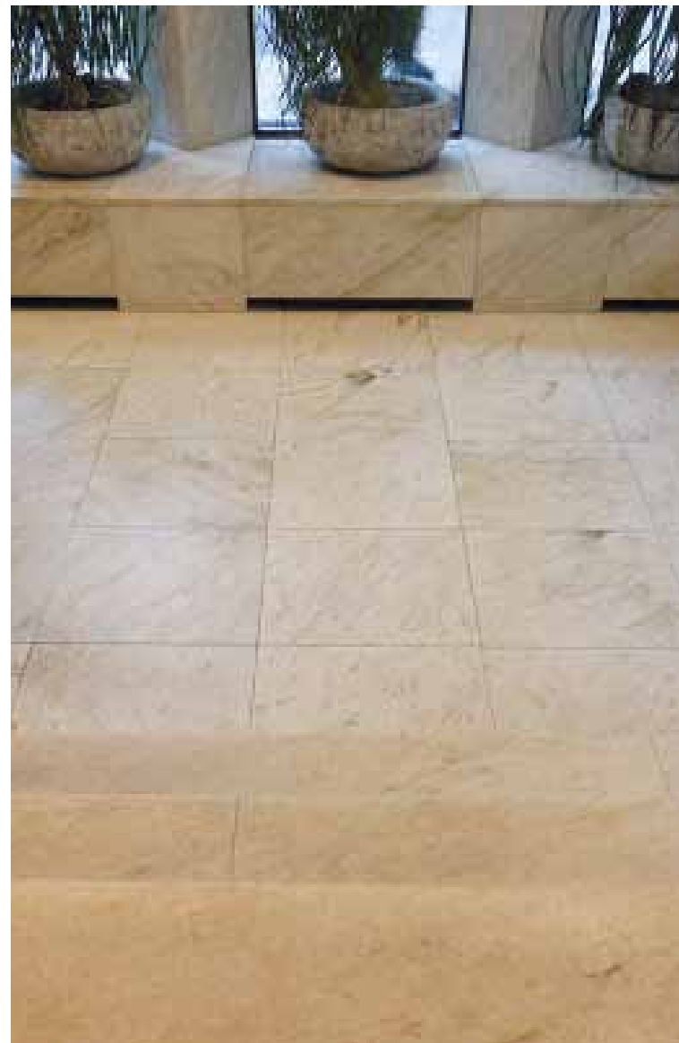
I Ingenjörshuset i Stockholm, nuvarande Citykonferensen, gäller den konsekventa användningen av Ekebergsmarmor även fönsterbänkarna, finslipad yta.
