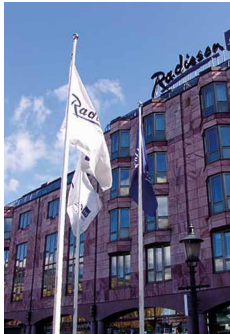
Beklädnaden av krysshamrad Älvdalskvartsit, har på fabrik monterats på betongelement som sedan lyfts på plats och bildat fasaden, i byggnadens fyra övre våningar. Stenens rödrosa färg och dess behuggnings ger byggnaden dess karaktär. Radisson Blu Scandinavia Hotel, Göteborg.
