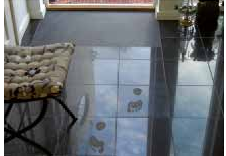
Innanför dörren; flammad diabas, halksäker, som samlar upp sand och smuts. Fotsår har blästrats in de polerade plattorna innanför.
