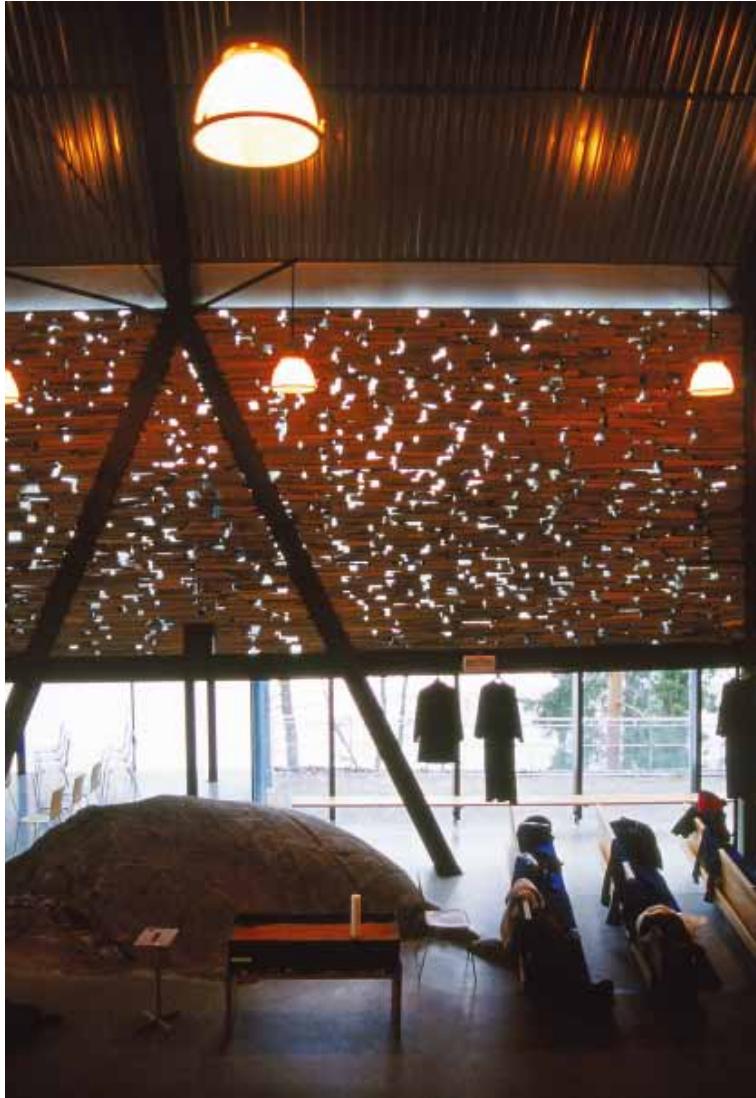
Mortenruds kyrka sydöst om Oslo har väggar i staplad skiffer som ger en robust karaktär av klippväggar i det öppna ljusa rummet. Den staplade muren, som ljuset silar igenom, vilar på en stålbalk. Bakom muren står en glasfasad. Arkitekter Jan Olav Jensen och Børre Skodvin.
