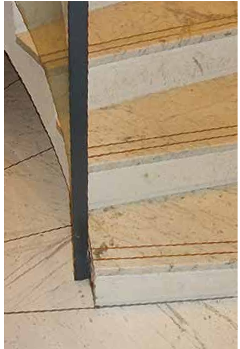
Louisiana Museum för Modern Konst i Humlebæk norr om Köpenhamn har en svängd trappa av slipad Carraramarmor med infrästa mässingslister, som ger kontrastverkan och fungerar som halkskydd.
