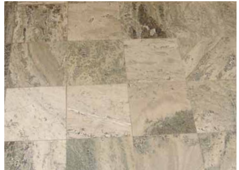
Kvadratiska plattor av slipad Kolmårdsmarmor. Genomgående fogar.
