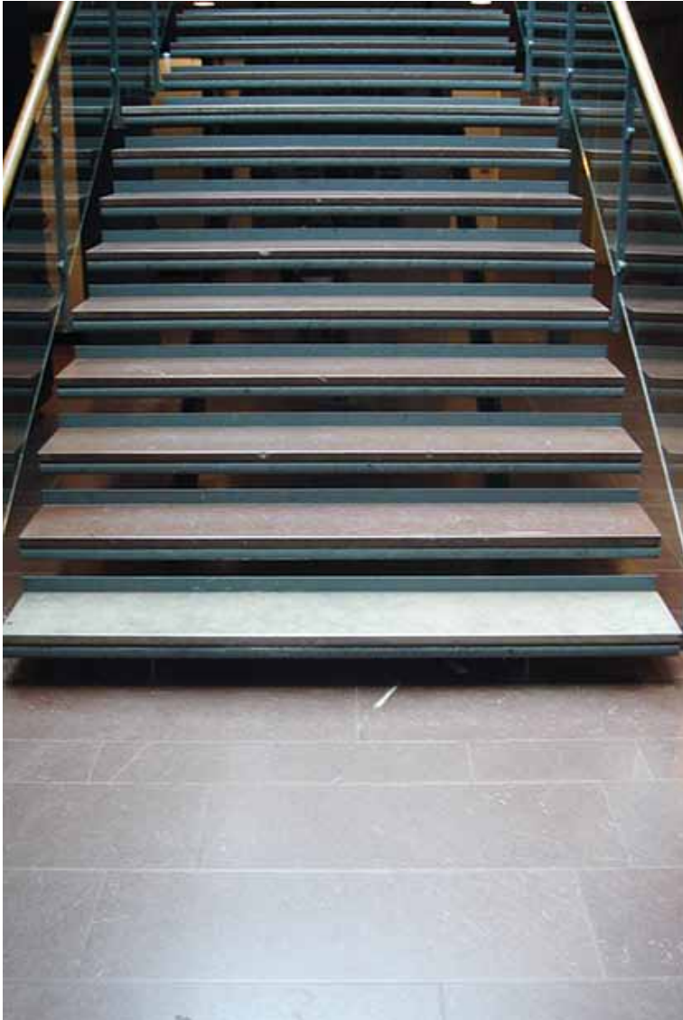
Trappsteg av slipad Olandsten G1 monterad på en stalkonstruktion. Trappans utformning signalerar det första steget med Carraramarmor i avvikande färg. Göteborgs Centralstation.
