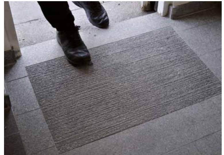
Spårsågning har här utförts i en befintlig golvyta, med gott resultat.
