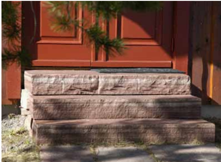
Blockstenstrappa av råkilad Älvdalskvartsit ger en robust åldrad karaktär.
