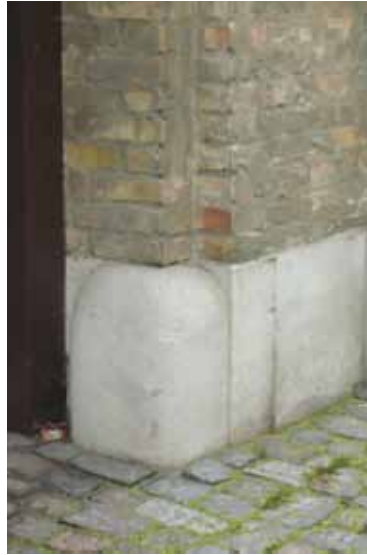
Skyddet är en del av sockeln.
