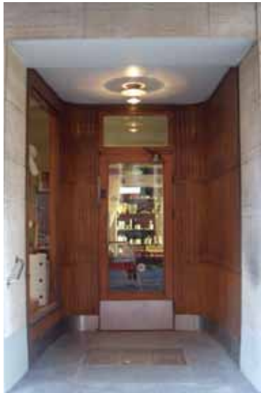
Entréöppning, skodd med travertin.
