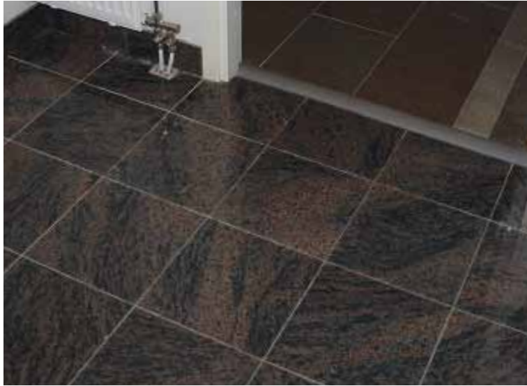
Polerad Hallandsgnejs, hållbar, lättstädad, lämplig för tuff, offentlig toalett.
