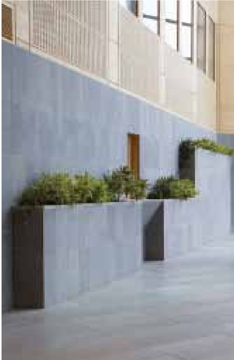
Denna bild från det stora Astra-komplexet i Mölndal visar väggar av Ölands, G2, som ger ett stabilt, men samtidigt ljust och lätt intryck. Arkitekt är Wingårdhs.
