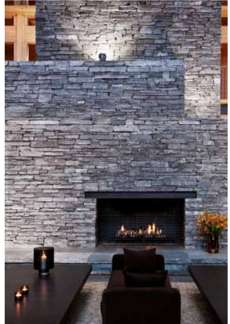
Kvartsitskiffer från Offerdal i Jämtland bygger rustika rum som för tankarna till gamla byggtraditioner. Här använd i Copperhill Mountain Lodge i Åre. Staplade smala plattor med bräckt framkant som kallmur, klamrad mot bakväggen. Arkitekt Peter Bohlin.
