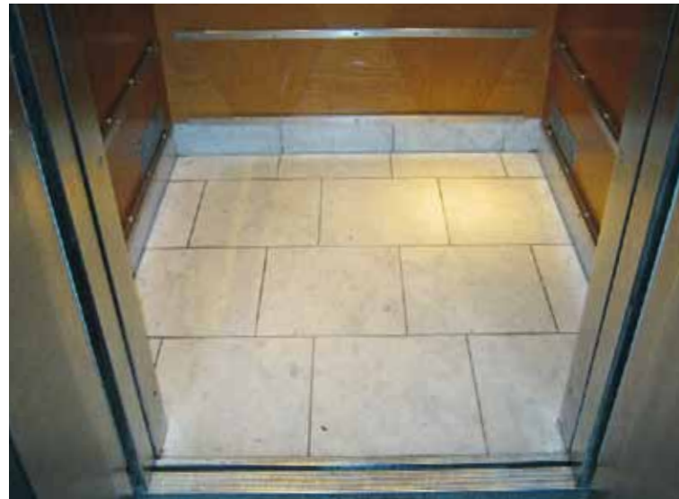
Golvet av slipad, ljus Ekebergsmarmor med kvadratiske plattor i förband.
