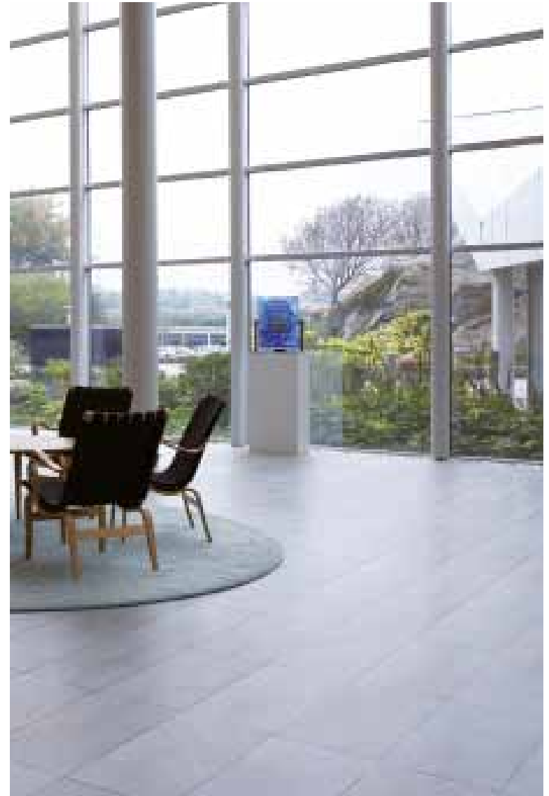
Golvplattorna av finhyvlat, grå Ölandskalksten, format 300×675 mm, med genomgående fogar i båda riktningarna. Detta ger rummet en egen karaktär. Astra-Hässle, Mölndal av Wingårdhs arkitektkontor.
