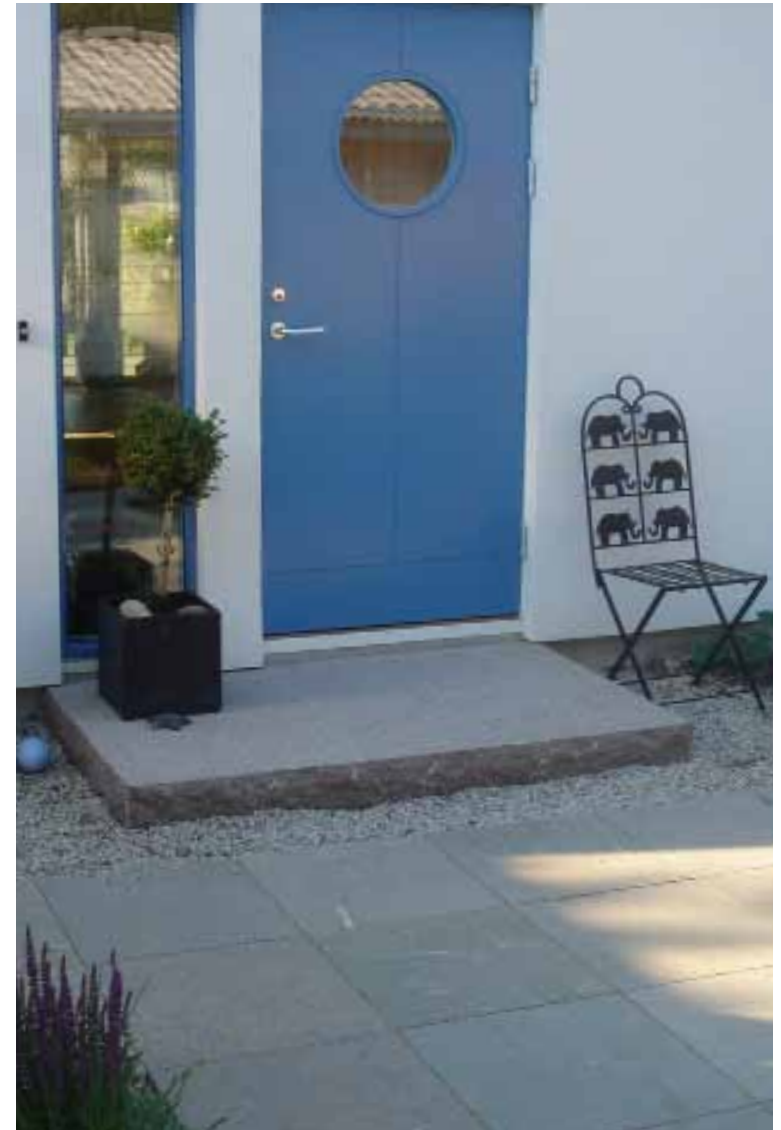
Som entré till en privatbostad är en naturstenstrappa solid och välkomnande på ett självklart sätt. Stenskivan är av krysshamrad röd Bohusgranit med råkilad sida.
