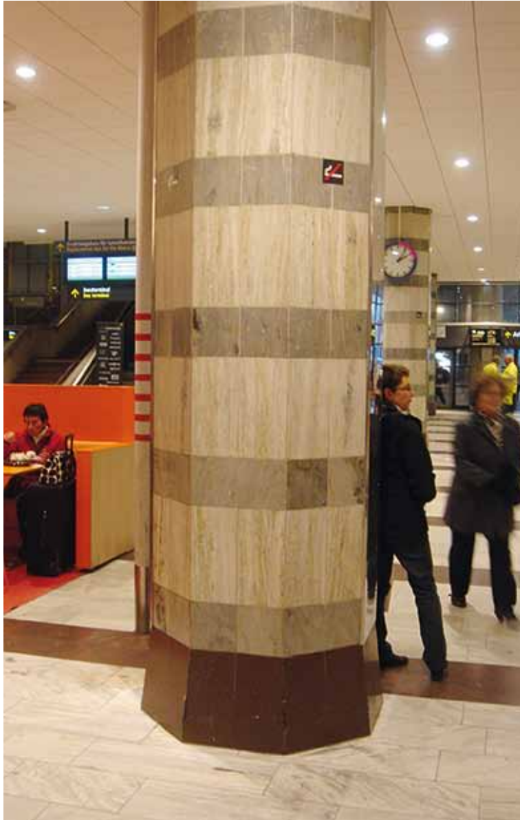
Av estetiska och funktionella skäl är denna pelarsockel tjockare i nertill.
