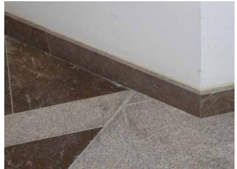
Rak sockel, 100 mm, av röd Ölandssten samspelar med golvet av samma sten.
