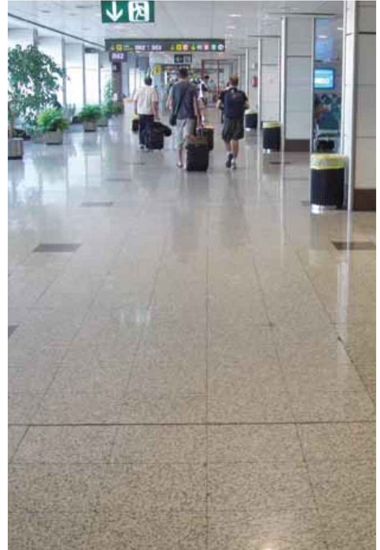
Detta polerade granitgolv med 2 mm fogar är från hållbarhets- och rengörings-synpunkt det bästa alternativet, lättstädad med miljövänligt rengöringsmedel. Beprövad granit ger ett nästan outslitligt golv. Bilden är från Madrids flygplats.
