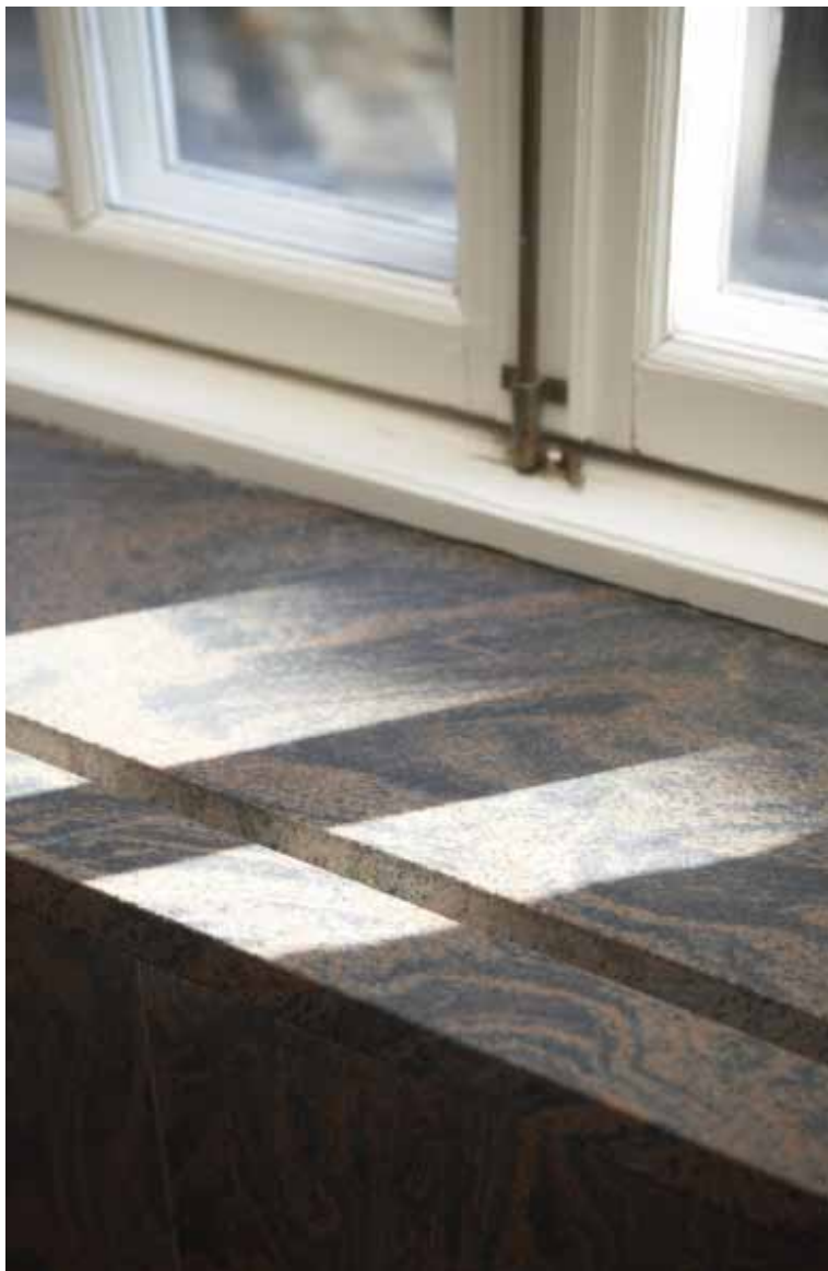
Fönsterbänken av ådrig gnejs har utförts med finslipad yta. Bänken är delad för att släppa upp radiatorvärmen.
