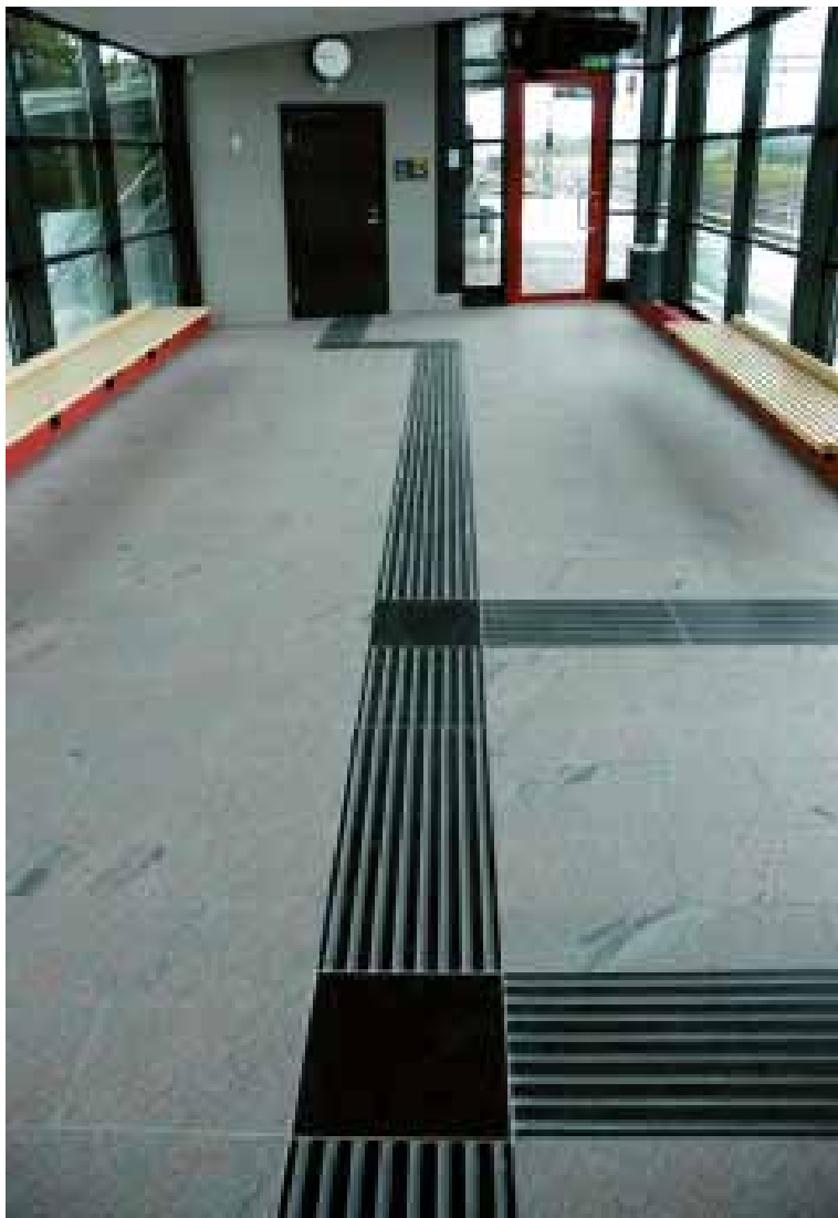
Falkenbergs järnvägsstation. Kombination av kontrastmarkering med taktil egenfunktion. Den mättade, svarta kulören hos den polerade diabasytan står i kontrast mot spårbottnens frästa, ljusare yta. Effekten förstärks ytterligare av kontrasten mot ytan på den flammade Hallandsgnejsen.
