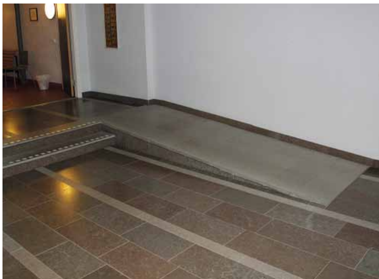
Ramp av hyvlad Ölandssten G1 bredvid trappa med kontrastmarkeringar.
