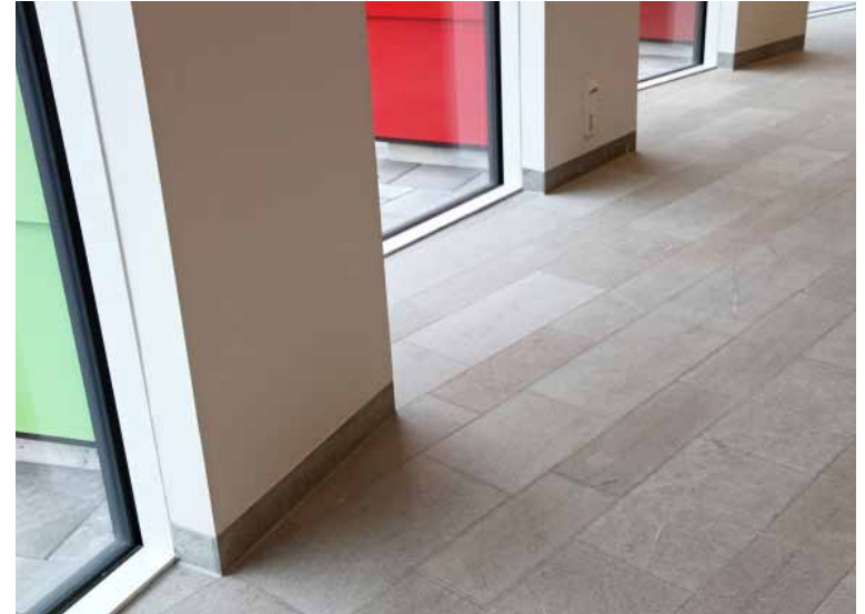
Infällda socklar ger en skarp arkitektonisk verkan. Ölandssten G2.
