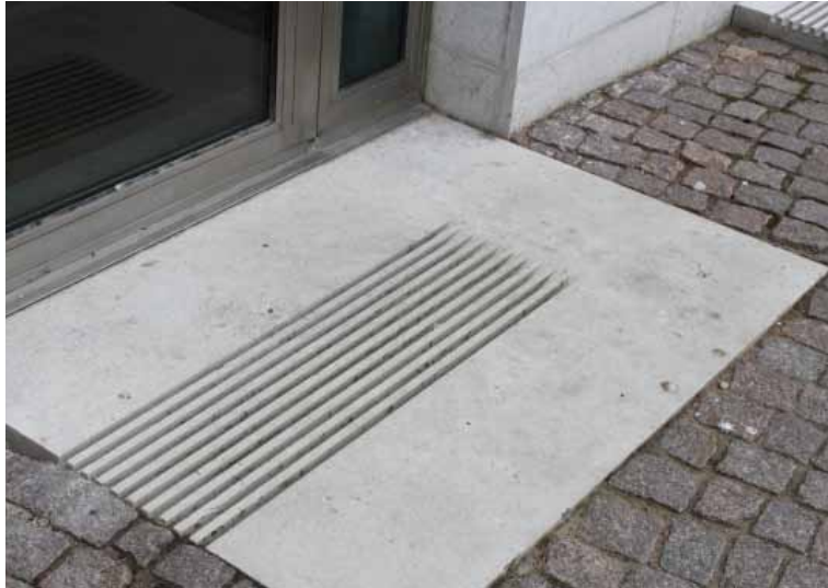
Detta skrapgaller har utförts som spårsågning i en häll av Norrvangekalksten. Helst bör man använda granit i detta utsatta läge.
