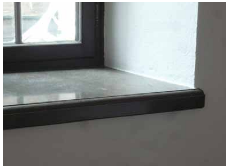
Fönsterbänk av kalksten, 40 mm tjock, med omsorgsfullt profilerad framsida.
