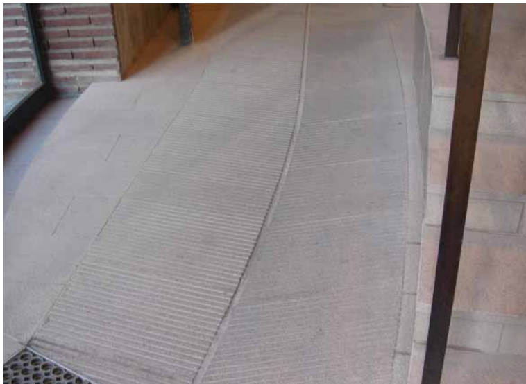
Citykonferensens entré. Spårsågad granit som skrapgaller, skurspår i mitten.
