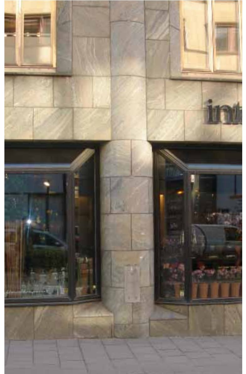
Kolonn, exklusivt beklädd med cylinderformad, slipad Ekebergsmarmor.
