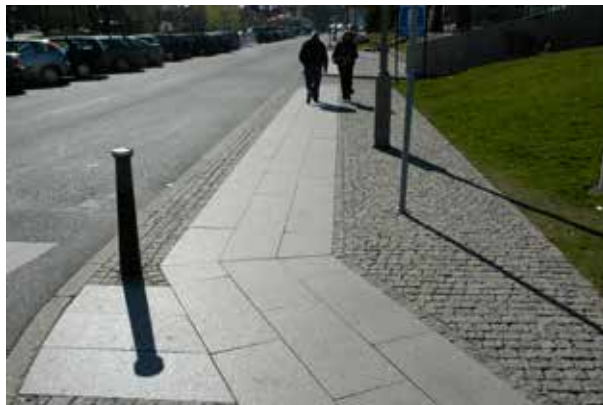
Fig 5.7 Rak stensättning/radsättning med granithällar inlagda som gångyta.
