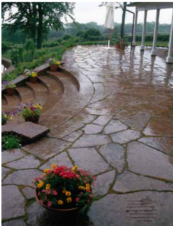
Fig 4.14 Altan med topphyvlad kalksten i oregelbundet mönster.
