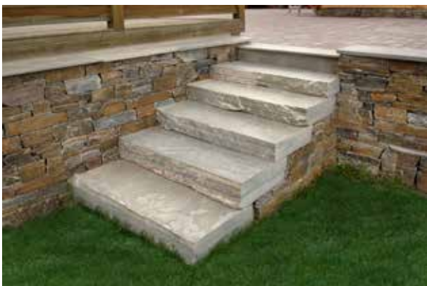
Fig 7.10 Blockstegstrappa av skiffer i anslutning till skifferkallmur.
