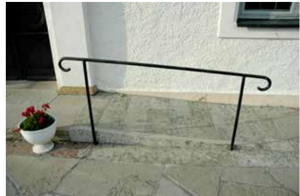
Fig 7.27 Låg ramp av kalksten för bättre tillgänglighet.
