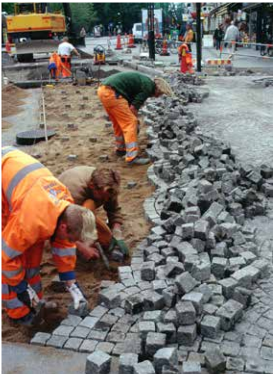
Fig 5.11 Bågsättning av smågatsten i obundet sättbruk/sand
