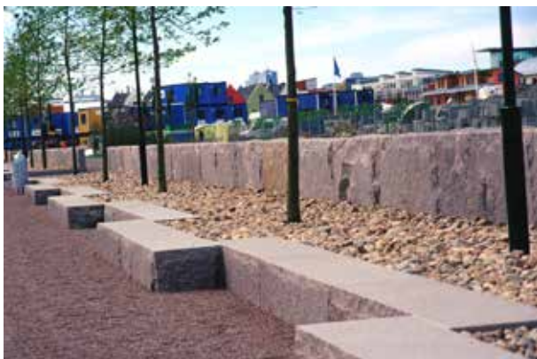
Fig 8.36 Två varianter av blockstensmur.
