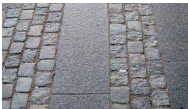
Fig 4.4 Granithäll med klippt kant mot gatstensbeläggning
