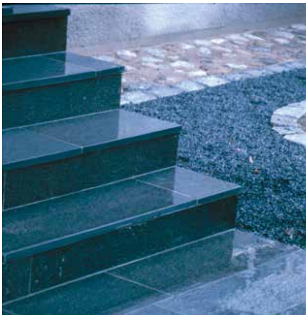
Fig 7.13 Beklädnadstrappa med steg av skiffer
