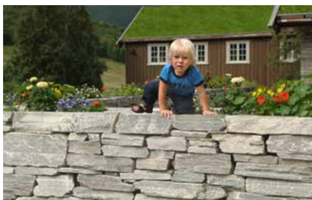
Fig 8.17 Kallmur av staplade skivor av skiffer
