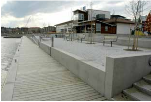
Fig 9.2 Kajläggning uppbyggd av granitblock med flammad yta.
