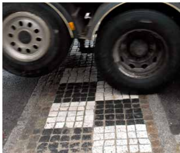
Fig 5.12 Gatsten med olika kulör markerar farthinder.
