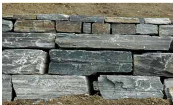
Fig 8.18 Kallmur av staplade skifferblock i kvaderförband.
