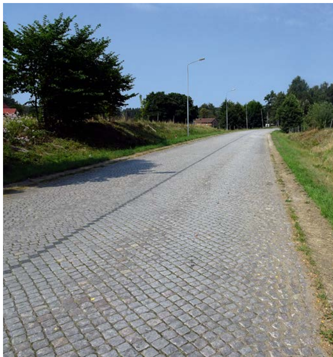
Vägsträckan av Rikstvåan utanför Ljungskile som förklarats som byggnadsminne
