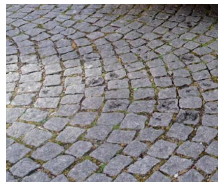
Samma stenkvalitet som på bilden till vänster, men med korrekt fog- och sättmaterial.
