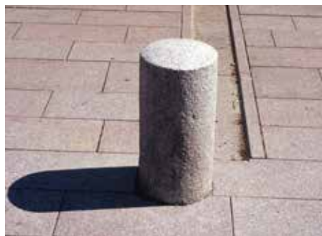
Fig 10.3 Cylindrisk, krysshamrad granitpollare. Rännstensplattor av flammad granit.
