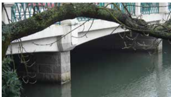
Fig 8.48 Brofundament klätt med beklädnadsganit med bakstöd av betong.
