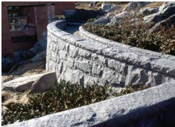
Fig 8.14 Mur av råkildad beklädnadsganit, avtäckning av råkildad granit.
