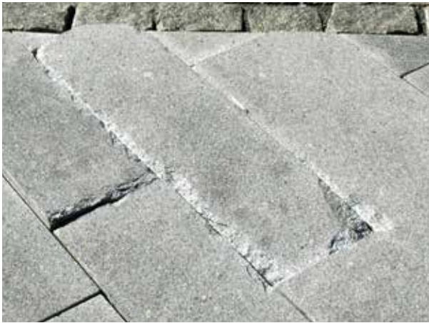
Fig 4.45 Granitbeläggning där plattkanterna har spjälkats ut. Smala fogar och alltför tung trafik i förhållande till underbyggnaden är troliga orsaker.
