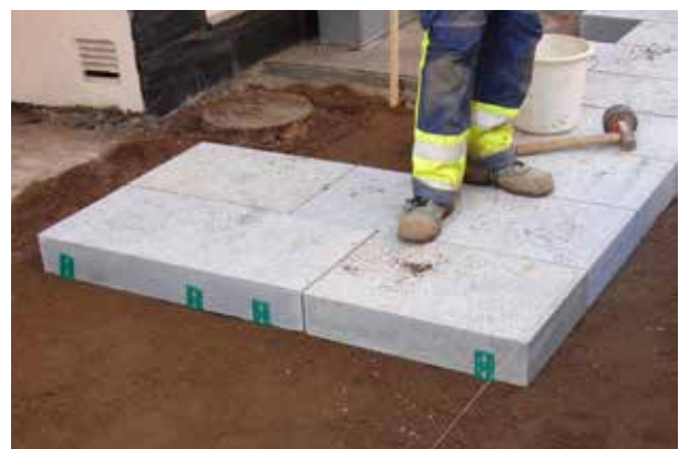
Fig 4.16 Distanser i fogarna hindrar att hällarna stöter emot varandra
