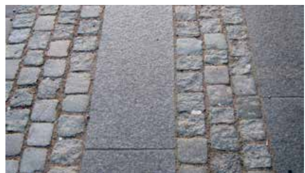
Fig 4.4 Granithäll med klippt kant mot gatstensbeläggning
