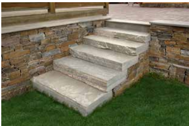
Fig 7.10 Blockstegstrappa av skiffer i anslutning till skifferkallmur.
