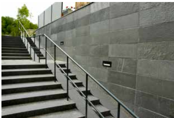
Fig 7.256 Barnvagnsramp integrerad i blockstegstrappa. Beklädnadsmur med skiffer.
