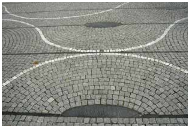
Fig 5.16 Smågatsten med olika kulör satt i objektpassat mönster.
