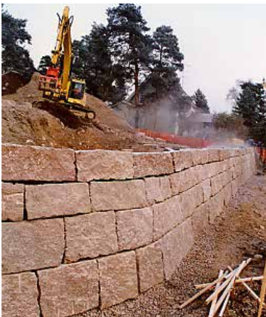
Fig 1.2 Kallmur av staplade råblock
