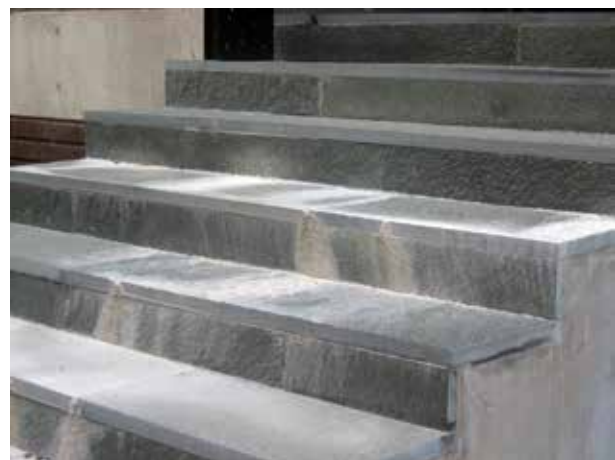
Fig 7.33 Misspyrdande salt- och kalkutfällningar, som är svåra att avlägsna. Sådana bildas när stora mängder vatten transporteras genom cementbruk.
