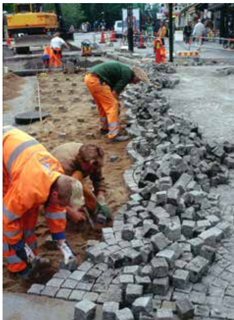
Fig 5.11 Bägsättning av smågatsten i obundet sättlager/sand
