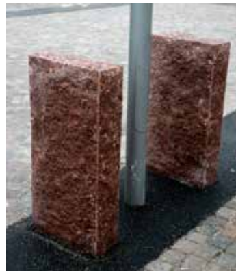
Fig 10.9 Påkörningsskydd av råkilad granit.
