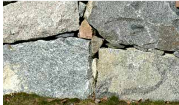
Fig 8.22 Mindre stenar, "skolsten" eller "lus" kilas in i stora fogar för att ge stabilitet.
