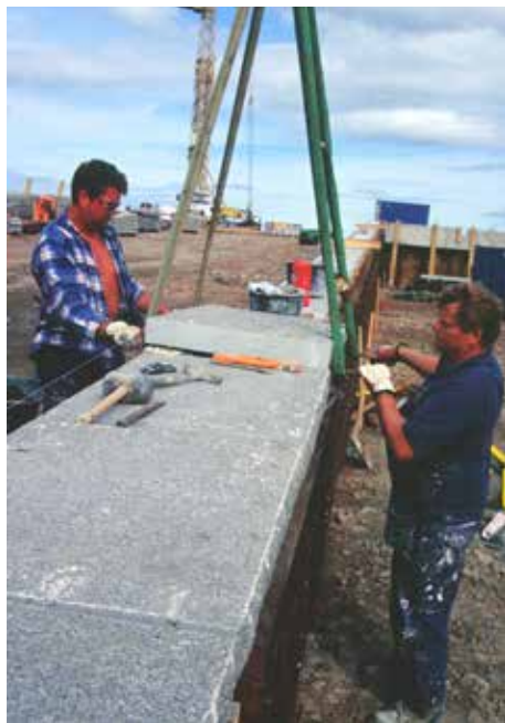
Fig 8.45 Granitavtäckning monteras
