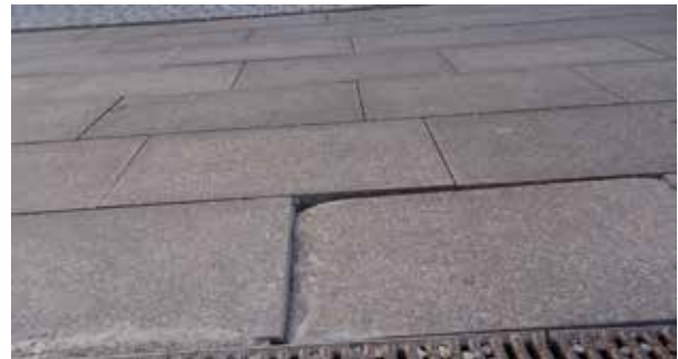
Fig 6 Plattan har kommit ur läge genom att komponenten fog har försvunnit.
