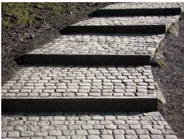
Fig 7.25 Åsnestig med sättsteg av kantsten och plansteg av gatsten
