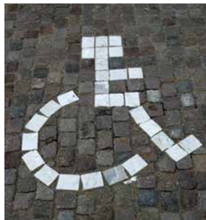
Fig 5.17 Gatsten med olika kulör kan användas för beständig markering i gatan.
