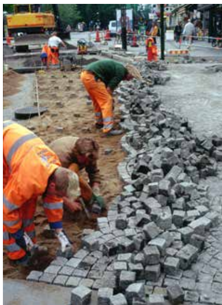
Fig 5.11 Bägsättning av smågatsten i obundet sättlager/sand
