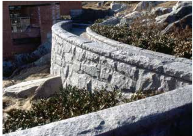
Fig 8.14 Mur av råkildad beklädnadsganit, avtäckning av råkildad granit.
