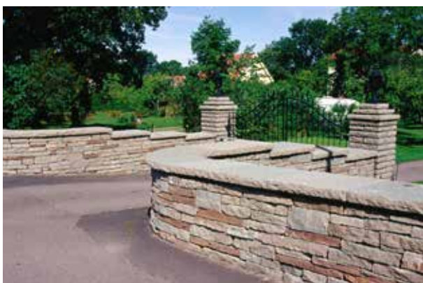
Fig 10.6 Grindstolpar och mur av kallmurad kalksten.
