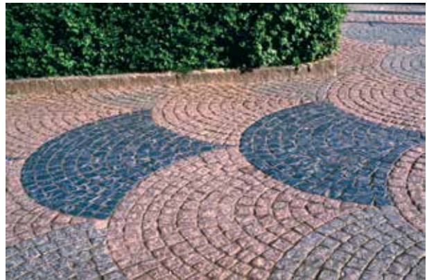
Fig 5.10 Påfågel-/fjärilssättning med smågatsten av röd och svart granit.
