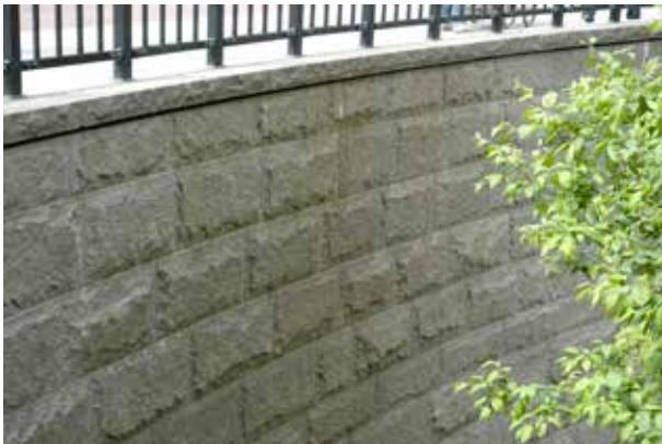
Fig 8.12 Svängd beklädnadsmur av grå granit med råkopp. Kvaderförband. Avtäckning av råkildad granit.
