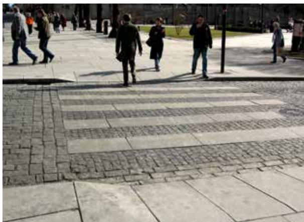
Fig 6.9 Tillgänglighetsanpassat övergångsställe.
