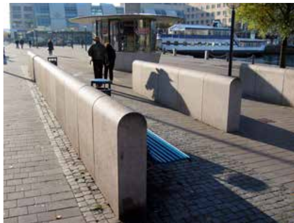
Fig 8.26 Blockstensmurar av flammad granit.
