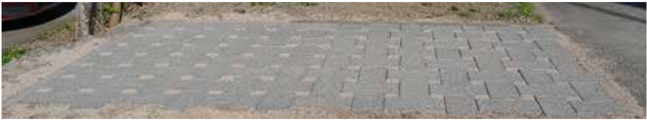
Fig 4.31 Dränerande parkeringsyta efter 4 års daglig användning
