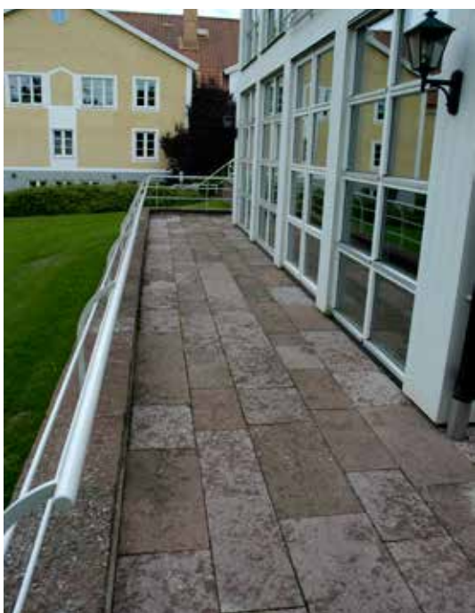
Fig 4.3 Toppfylade kalkstenshällar i fallande längder
