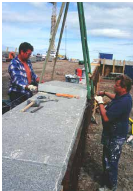
Fig 8.45 Granitavtäckning monteras
