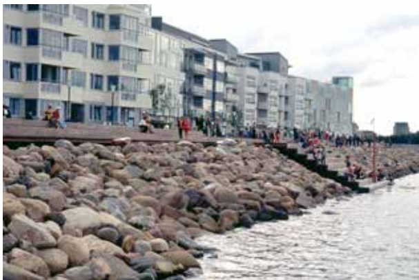
Fig 8.41 Släntbeklädning uppbyggd av runda fältstenar, som erosionsskydd mot havet.
