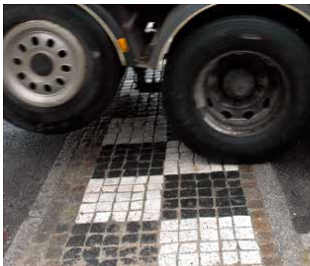
Fig 5.12 Gatsten med olika kulör markerar farthinder.
