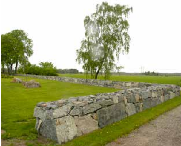
Fig 8.27 Kallmur av lokal sten, s k kyrkogårdsmur.
