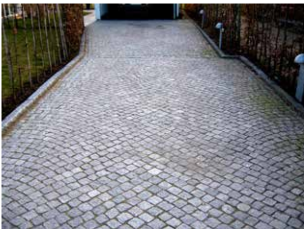
Fig 5.9 Diagonalsättning med smågatsten
