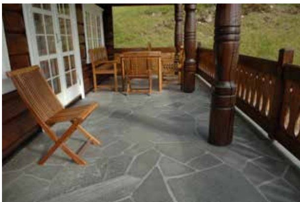
Fig 4.37 Altanbeläggning, skiffer med klovyta.
