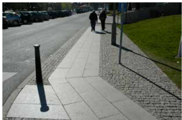
Fig 5.7 Rak stensättning/radsättning med granithällar inlagda som gångyta.
