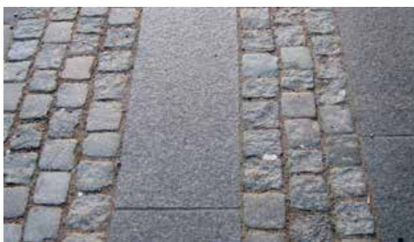
Fig 4.4 Granithäll med klippt kant mot gatstensbeläggning
