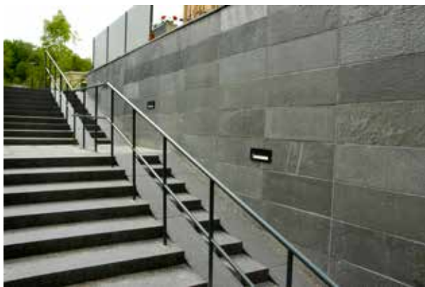
Fig 7.256 Barnvagnsramp integrerad i blockstegstrappa. Beklädnadsmur med skiffer.
