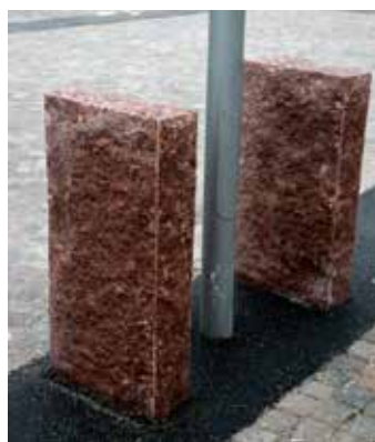
Fig 10.9 Påkörningsskydd av råkilad granit.
