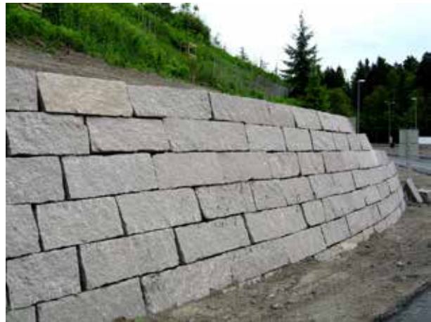
Fig 8.29 Kallmur av granitblock i vägsränning.
