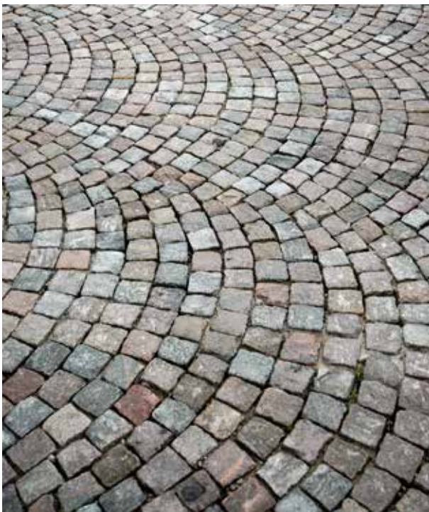
Fig 5.8 Bågsättning med smågatsten
