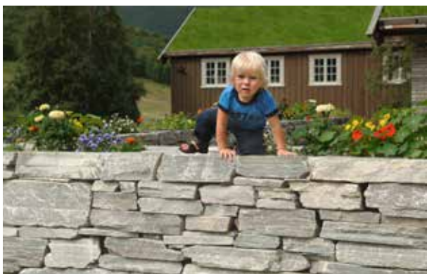
Fig 8.17 Kallmur av staplade skivor av skiffer
