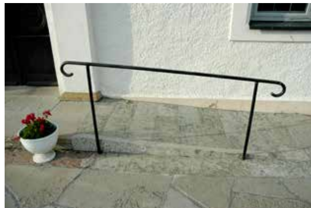
Fig 7.27 Låg ramp av kalksten för bättre tillgänglighet.
