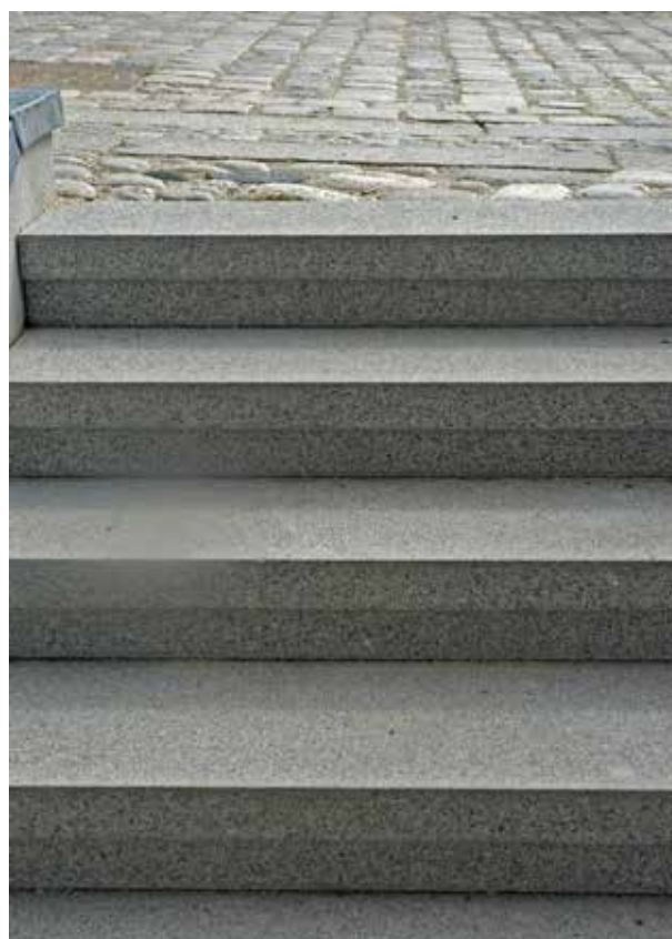
Fig 7.3 Beklädnadssteg av krysshämrad granit
