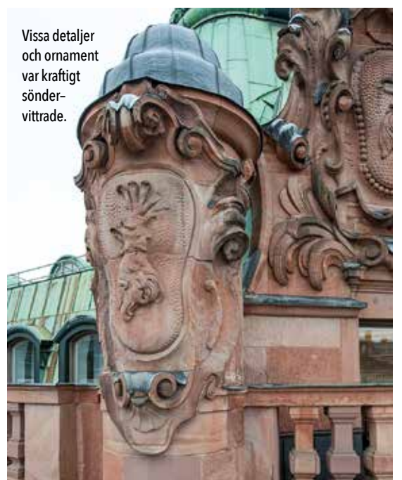
Merparten av all ornamental och skulptural sten som har behövt nyhuggas har gjutits av, och gipsmodellerna har skickats till stenhuggeriet Steinhauerei Hartwig i Springe, Hannover.
