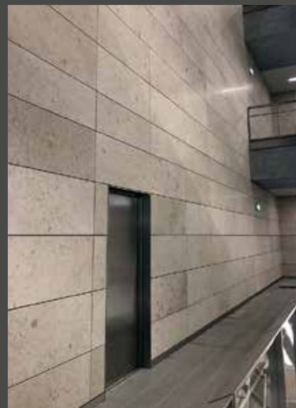
1 300 kvadratmeter kalksten har Slite Stenhuggeri levererat till Fredriks kirkes tunnelbanestation i Köpenhamn.
