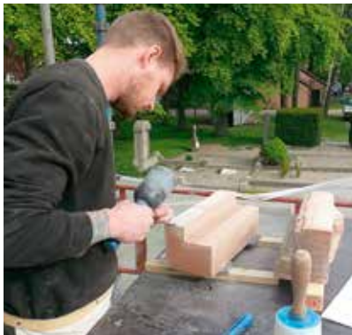
Slutbearbetning, behugning sker manuellt i vårt stenhuggeri eller ute på restaureringsobjekt.
