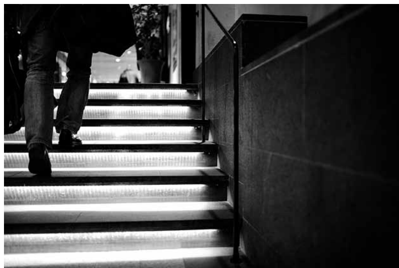
▲ I Moodgallerian i Sahlénhuset i Stockholm har man arbetat konsekvent med flammad Brännhultsdiabas i fasad, murar och trappor. Golvet består av grå Bohusgranit med flammad yta.
