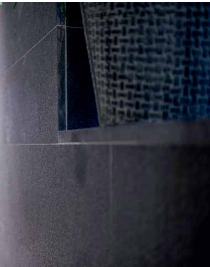
Sveriges ambassad i Berlin har fasad av svart polerad diabas från Emmaboda Granit.
