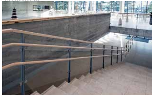
Den ljusa och välkomnande entréhallen med utsikt över trädtopparna och Baggensfjärden. Trappa av normalslipad Norrvangekalksten.
