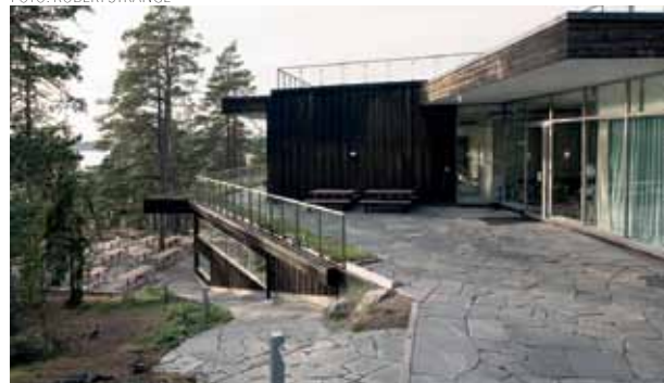
Skifferplattor ligger på terrasser kring byggnaden och som gångstråk på taket.
