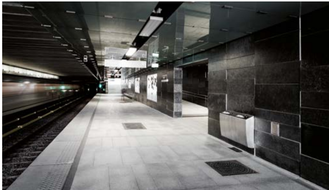
Veggen har fått et spennende uttrykk gjennom at det er valgt ulike bredder og tykkelser på Ottaskiferen som deretter er montert i et fast mønster.
