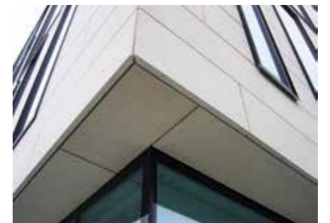
Gyldengården med sin sandstensfasad. Foto Danielsen Architecture
