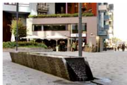
Vanntrauet på Olav Selvaags plass er hugget ut i mørk kinesisk granitt G 654. Dette gir god speileffekt av vannet før det løper via et frisk vannfall til vannrennen gjennom gaten. Foto Nils Petter Dale.
