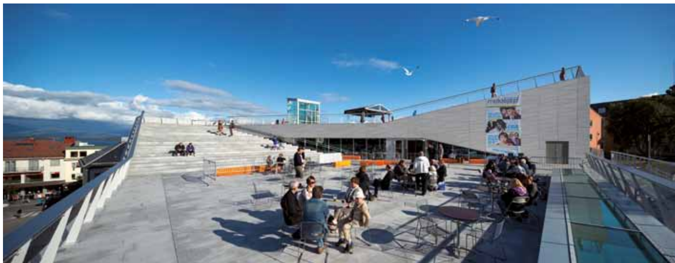
Beliggende midt i byen og med udsigt over både fjord og fjeld udgør kulturhuset Plassen i Molde et oplagt mødested. Med en optimal udnyttelse af hver enkelt kvadratmeter, har 3XN skabt et byggeri, der kan fungere både når 100 og 100.000 mennesker samles til koncerter, festivaler eller teater.
