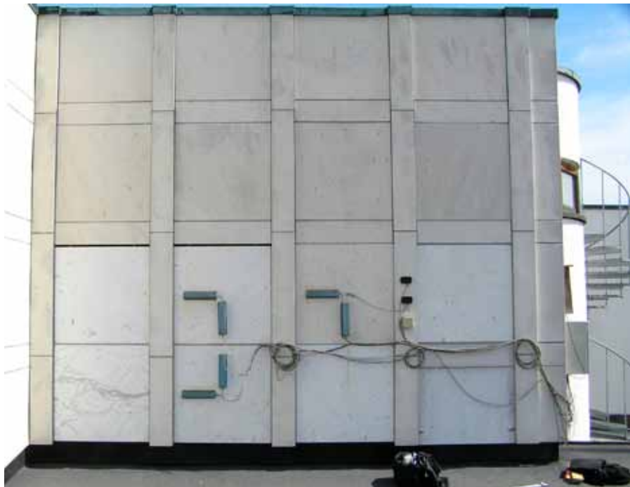
Fältprovningsplats på taket av stadshuset
