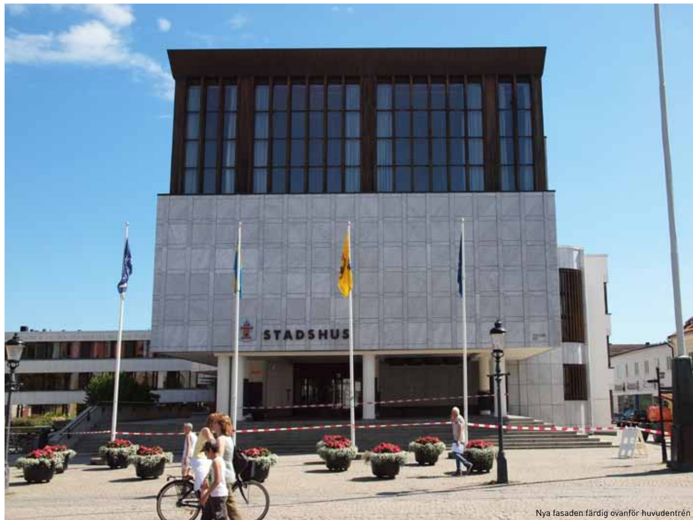
Nya fasaden färdig ovanför huvudentrén.
