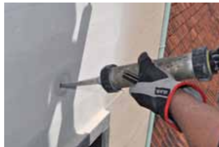
Ankarmassa injekteras för infästning av dubb. Foto Marmor & Granit
