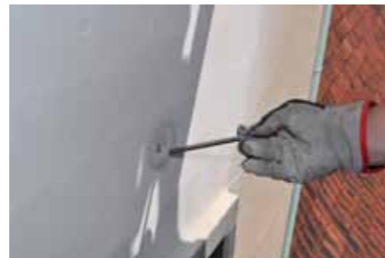
Syrafast, rostfri dubb monteras. Foto Marmor & Granit
