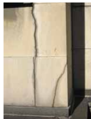
Underkant burspråk var fasadplattor av Ekebergsmarmor spräckta och listverk av Fjäråsgnejs förskjutna. Foto Christer Kjellén
