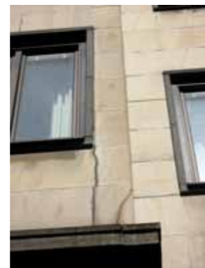
Underkant burspråk var fasadplattor av Ekebergsmarmor spräckta och listverk av Fjäråsgnejs förskjutna. Foto Christer Kjellén
