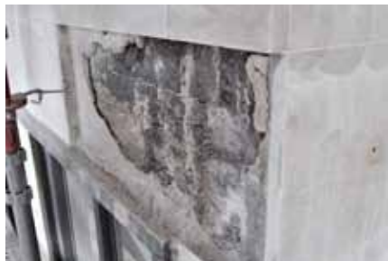
Spräckt platta har demonterats. Foto Marmor & Granit
