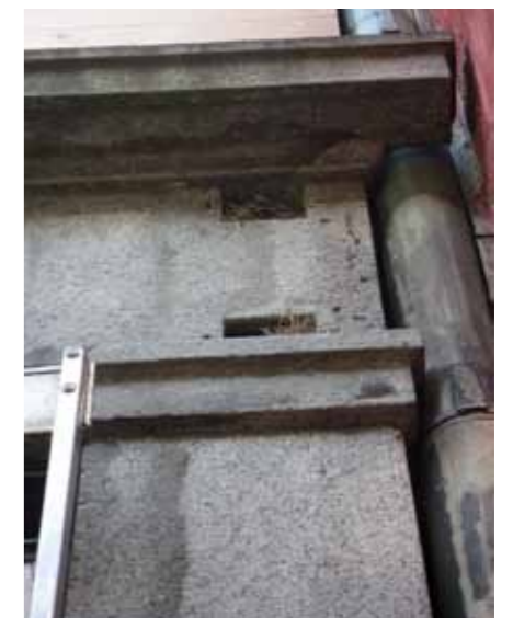
I bottenvåningen fanns bland annat hått efter infästningar och installationer. Foto Christer Kjellén
