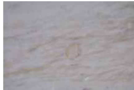
Sedan hålet lagats med stenlagning är infästningen så gott som osynlig. Foto Marmor & Granit
