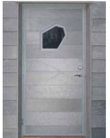
Designet dør laget for å tåle vekten av oppdalsskiferen i front, vindu formet som en TrællHelle.
