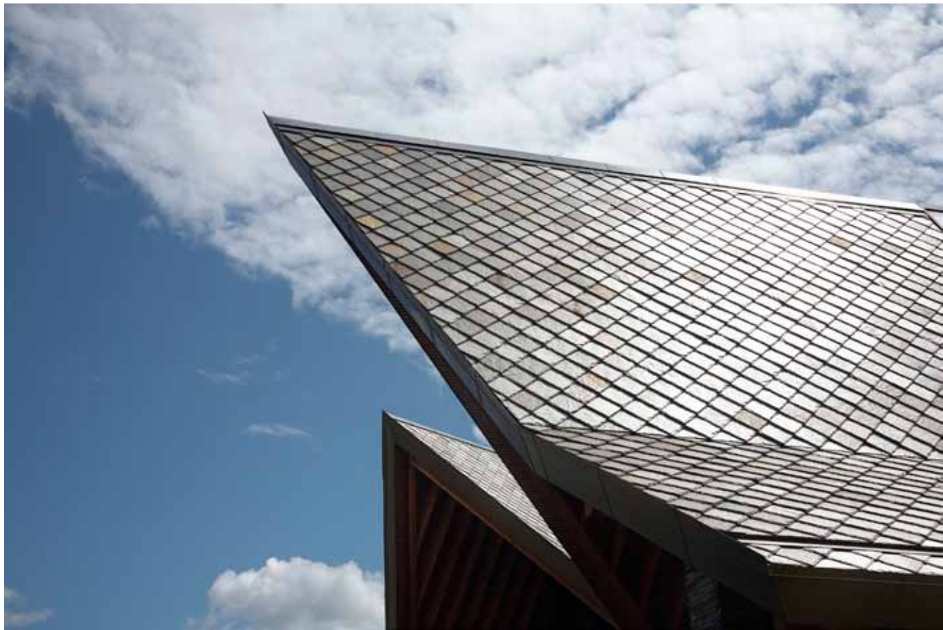
Takeene er det belagt med klipt 15" x 15" firkantstein i Ottaskifer med naturplan. Foto Thorbjørn Hansen
