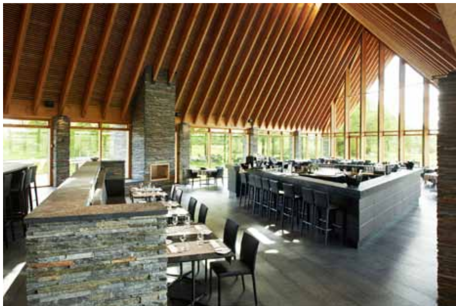
I restaurantavdelingen er det bakstøpt tørrmur i Ottaskifer i murene som deler øvre og nedre nivå og i skorsteinen med innebygd peis. Gulvene er i Ottaskifer med børstet overflate. Foto Thorbjørn Hansen
