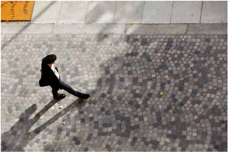
Smågatstensytorna är lagda i bågmönster och består av fyra olika sorter sten för att ge ett levande uttryck. Foto Stéfan Estassy
