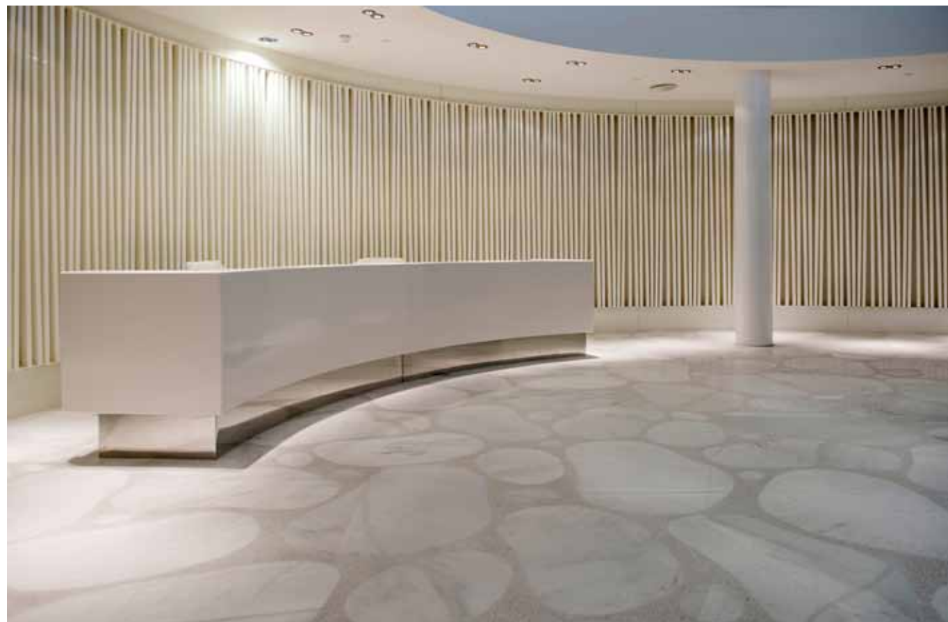
Foyeren er et sirkulært rom over to etasjer som forbinder byggets fellesarealer. På gulvet er lekt med marmor i store organiske former som er lagt i terrazzo, også med Bianco Macael marmor som er knust.
