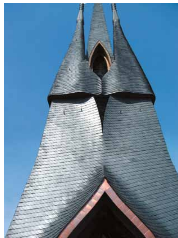
Organiske former skapas med hjelp av takskiffer. Paks kyrka i Ungern
