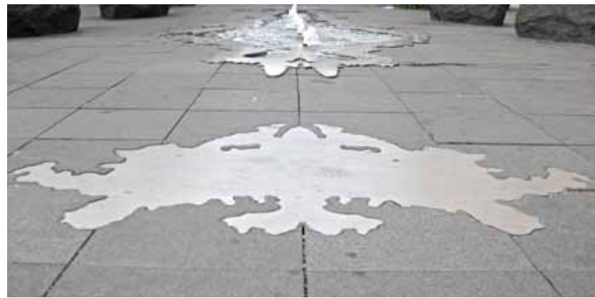
De inprästa stålfigurerna sträcker sig över flera hållar, vilket kräver stor precision både vid fräsning och montering. Foto: Robert Kjellén
