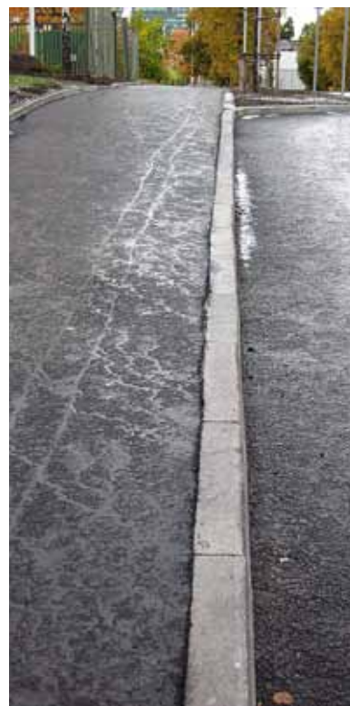
Stensättningen håller inte linjen
