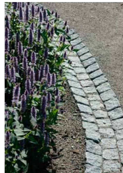
Ränndalar av smågatsten leder regnvattnet till brunnarna.
