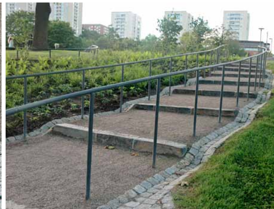
En trappväg av stenmjöl (så kallad Eco-yta, för minskad erosion) och sättsteg av svart grythytteskiffer.
