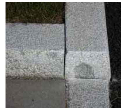
Kapade ändar måste ytbearbetas
