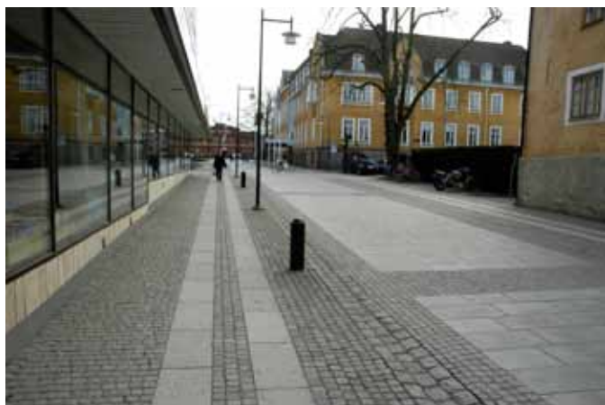
Gatstensbeläggning med gångstråk och fält av granithällar.
