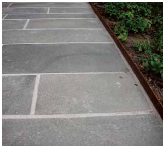
Overgangen mellom belegning og plantefelt.
