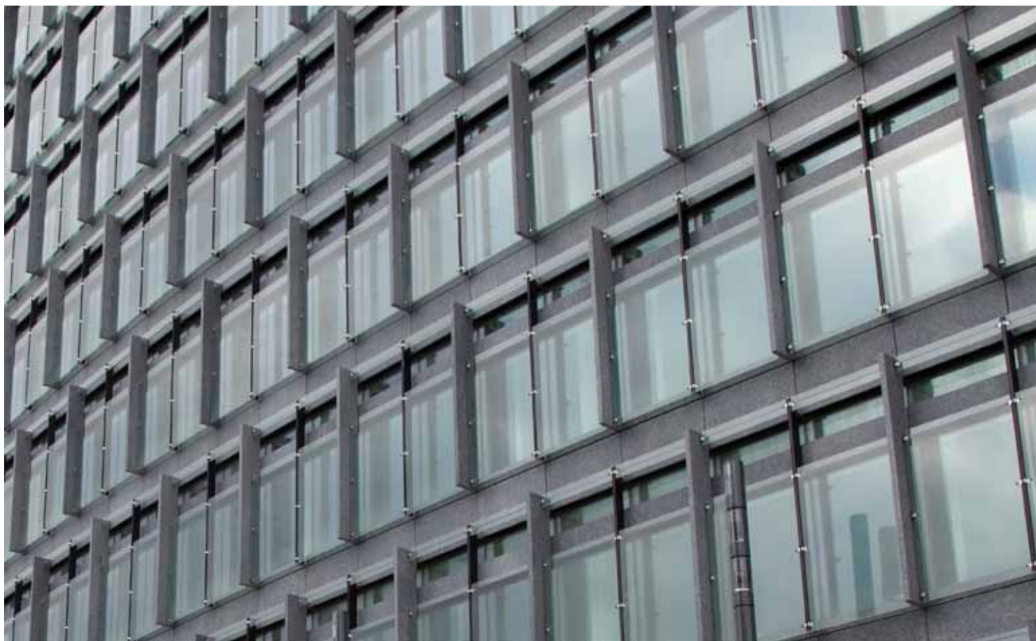
De slanke granitfiner, der er en del af solafskærmningen, giver facaden dybde. Foto: Lars Kaae
