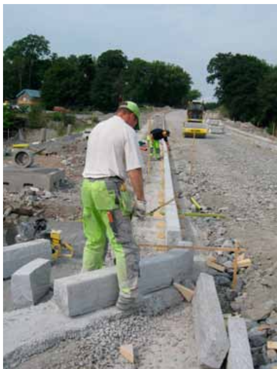
Montering av kantsten, GF1
