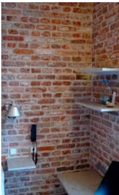
Indmurede hylder og borde i kalksten. Foto: Christer Kjellén
