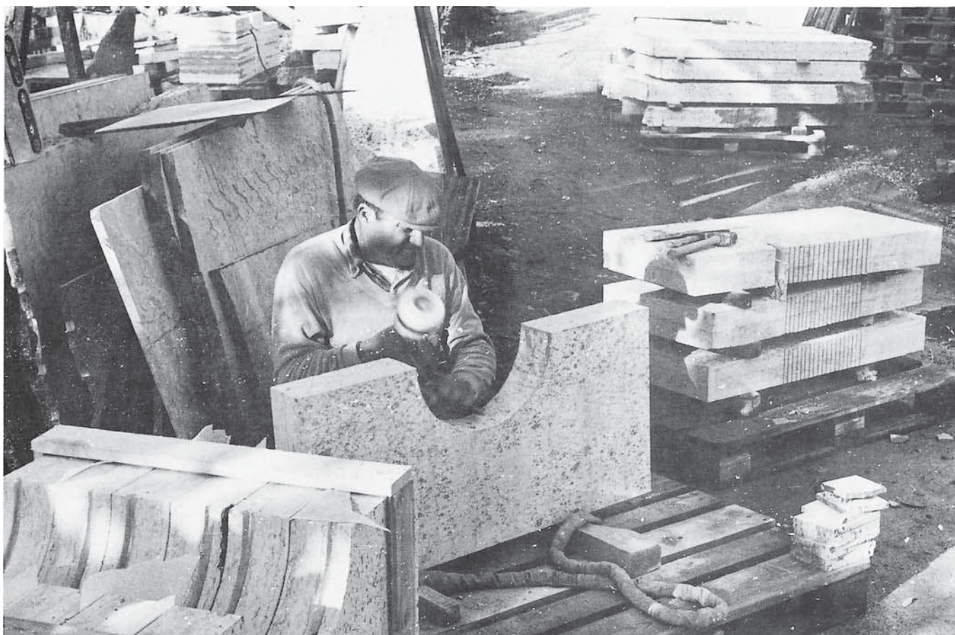
Hugning av kalksten för hand med klubba och mejsel.
