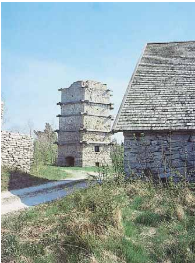
I Barlast på Gotland står alltjämt en gammal kalkstensugn från 1700-talet. Murverket hålls samman av kraftiga ringar av trä.
