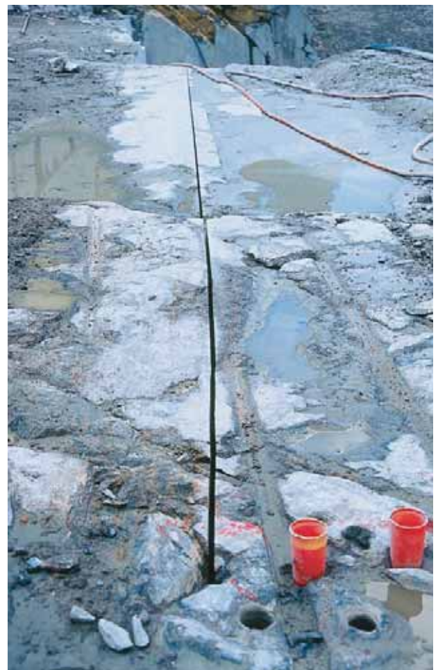
Wiresågad söm för friläggning av pallens ände.
