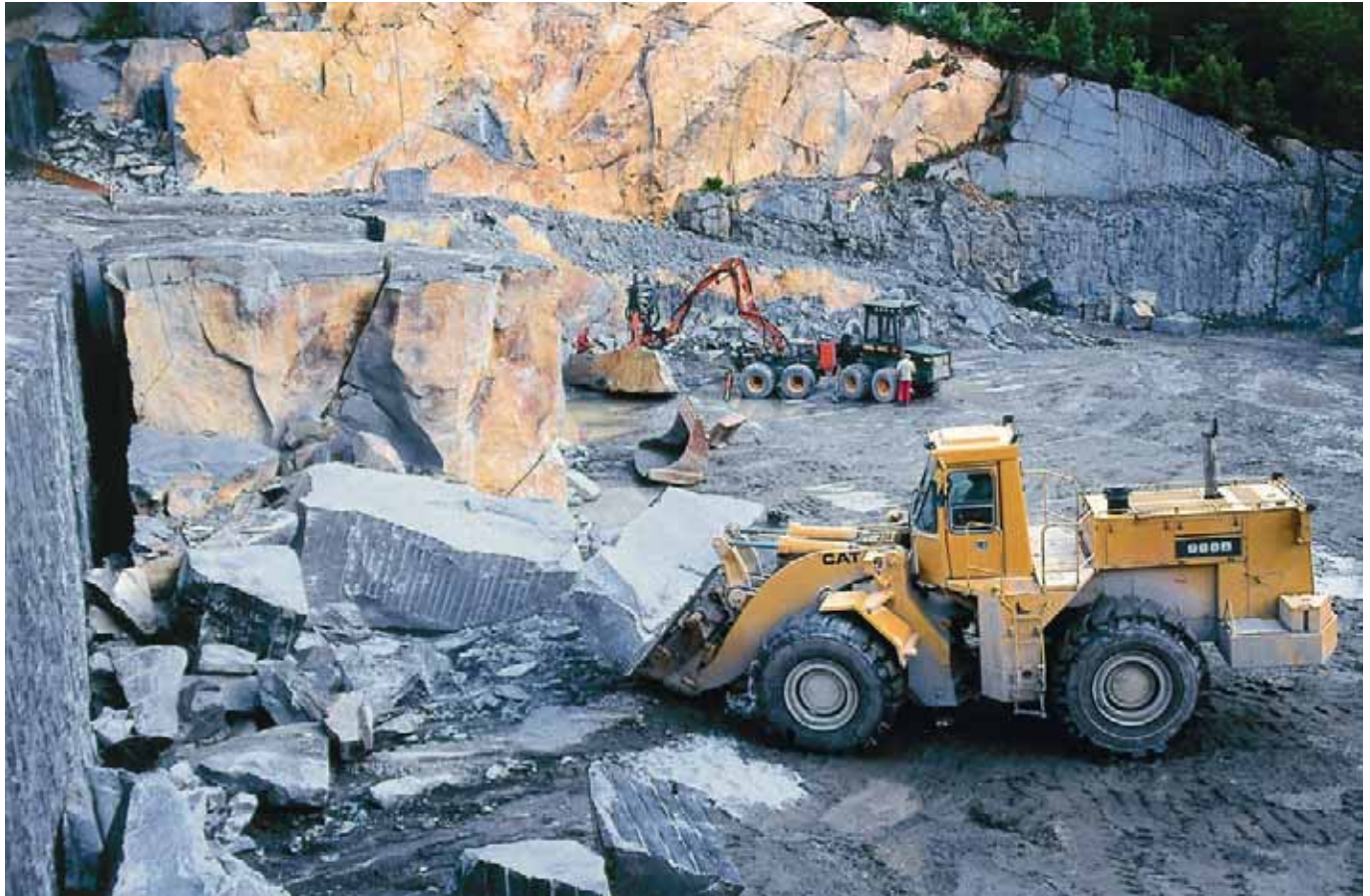
Jättelika lastmaskiner är till stor hjälp vid brytningen och hanteringen av stenblock.
