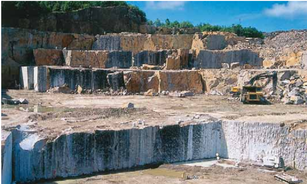
Granitbrott i Halland. Hydrauliska bormaskiner i riggar användes för horisontell och vertikal bormning i kombination med wiresågning.
