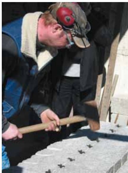
Tillverkning av kantsten sker med enkla metoder (råkilning) även i Sverige
