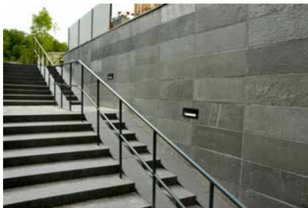
Fig 7.25 Barnvagnsramp integrerad i blockstegstrappa. Beklädnadsmur med skiffer.
