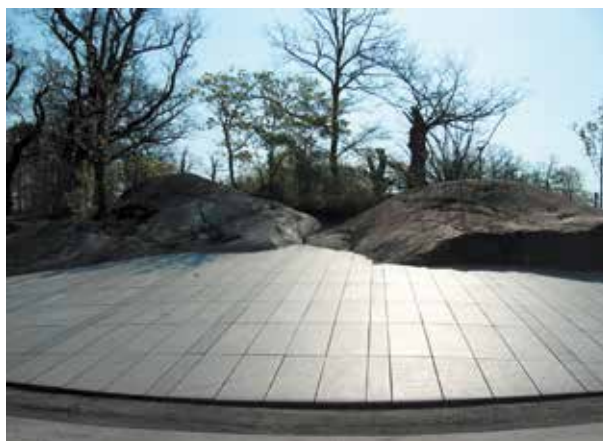
Fig 8.43 Släntbeklädning av granitplattor i parkmiljö.
