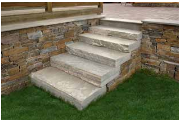
Fig 7.10 Blockstegstrappa av skiffer i anslutning till skifferkallmur.
