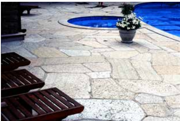
Fig 4.22 Topphyvlat kalksten i oregelbundet mönster runt pool.
