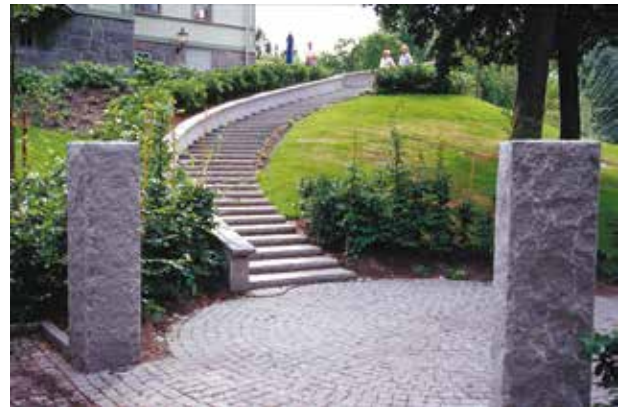
Fig 10.4 Grindstolpar av råkilad granit.
