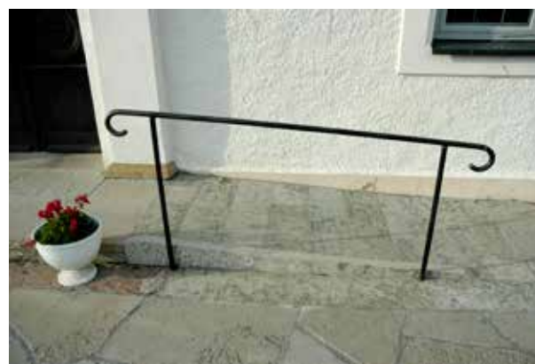
Fig 7.26 Låg ramp av kalksten för bättre tillgänglighet.
