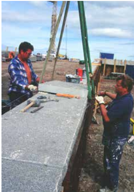
Fig 8.46 Granitavtäckning monteras
