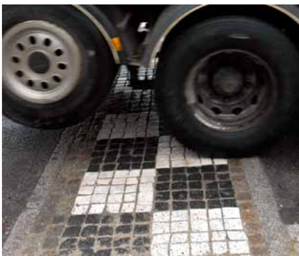
Fig 5.12 Gatsten med olika kulör markerar farthinder.
