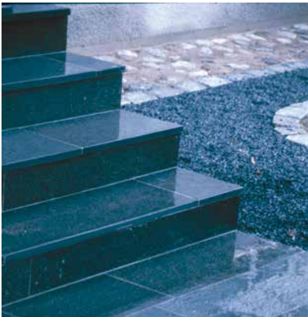
Fig 7.13 Beklädnadstrappa med steg av skiffer
