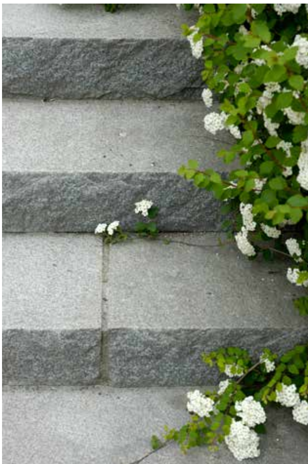
Fig 7.2 Blockstegtrappa av granit. Kryssharnad ovsida och råkilad framsida.
