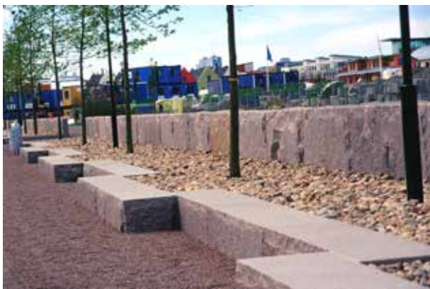
Fig 8.35 Två varianter av blockstensmur.
