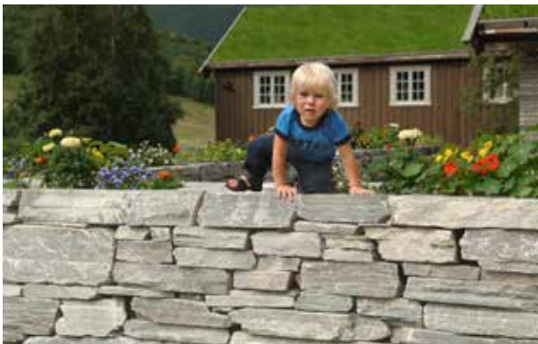
Fig 8.17 Kallmur av staplade skivor av skiffer
