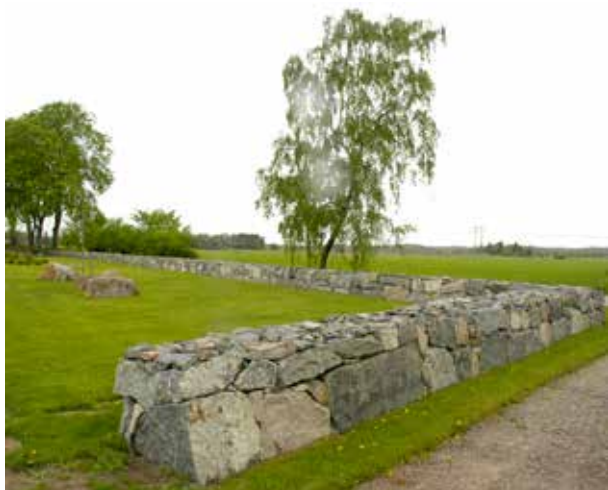
Fig 8.27 Kallmur av lokal sten, s k kyrkogårdsmur.
