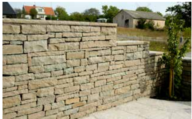
Fig 8.19 Kallmur av kalkstensskivor med avtäckning lagd i bruk
