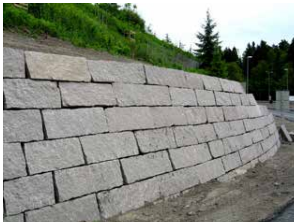
Fig 8.29 Kallmur av granitblock i vägskäring.
