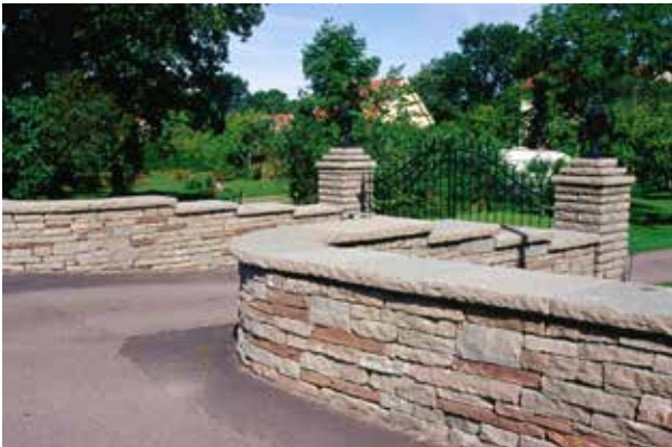
Fig 10.6 Grindstolpar och mur av kallmurad kalksten.
