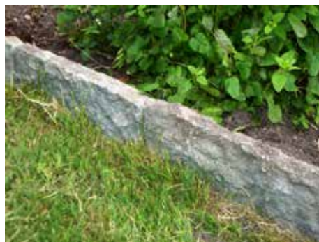
Fig 6.19 Trädgårdskantsten av kalksten
