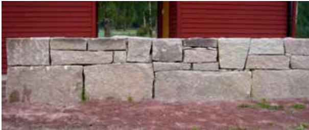
Fig 8.7 Kallmur av granitblock i rubbelförband
