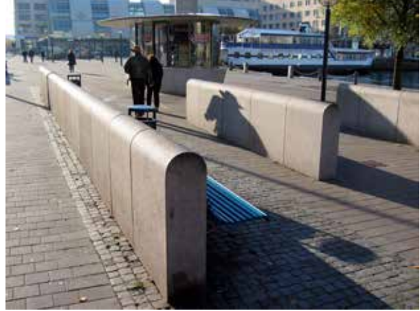
Fig 8.26 Blockstensmurar av flammad granit.
