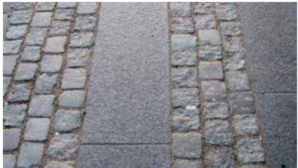
Fig 4.4 Granithäll med klippt kant mot gatstensbeläggning
