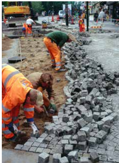
Fig 5.10 Bågsättning av smågatsten i sand
