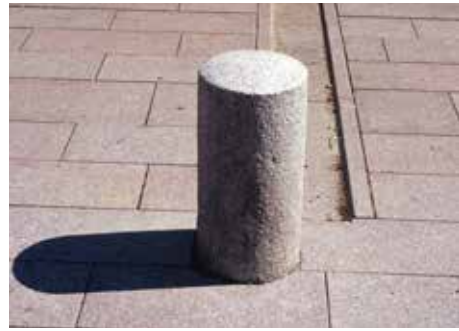
Fig 10.3 Cylindrisk, krysshamrad granitpollare. Rännstensplattor av flammad granit.
