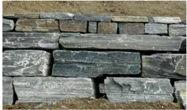
Fig 8.18 Kallmur av staplade skifferblock i kvaderförband.
