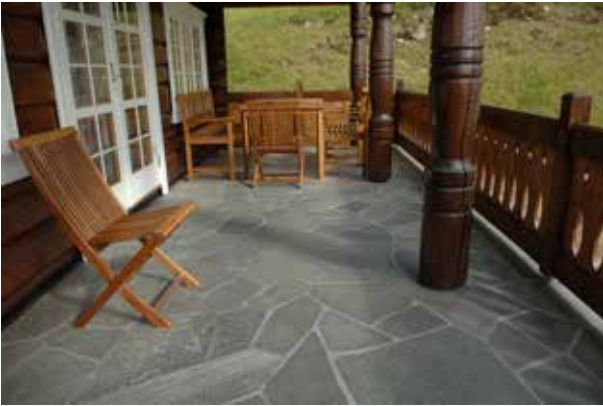
Fig 4.29 Altanbeläggning, skiffer med klovyta.
