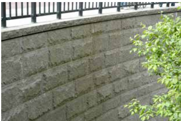
Fig 8.12 Svängd beklädnadsmur av grå granit med råkopp. Kvaderförband. Avtäckning av råkilad granit.
