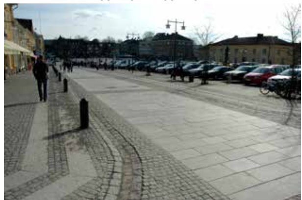
Fig 4.24 Gärtdsgata med beläggning av granithällar och smågatsten
