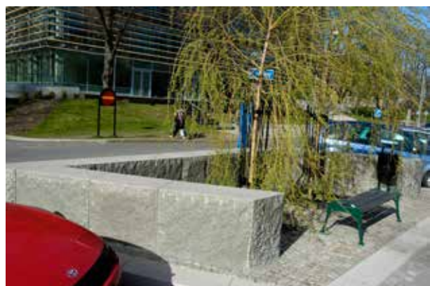
Fig 8.11 Blockstensmur av råkilade granitblock bildar pausmiljö i gatubilden.
