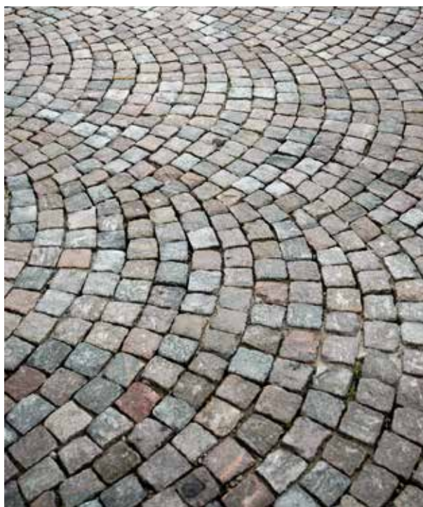
Fig 5.7 Bågsättning med smågatsten
