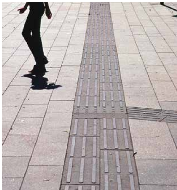
Fig 1.9 Torgyta med taktill markering för vägledning för synsvaga.
