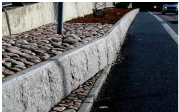
Fig 8.48 Blockstensmur av granit som stödmur och trafikbarriär
