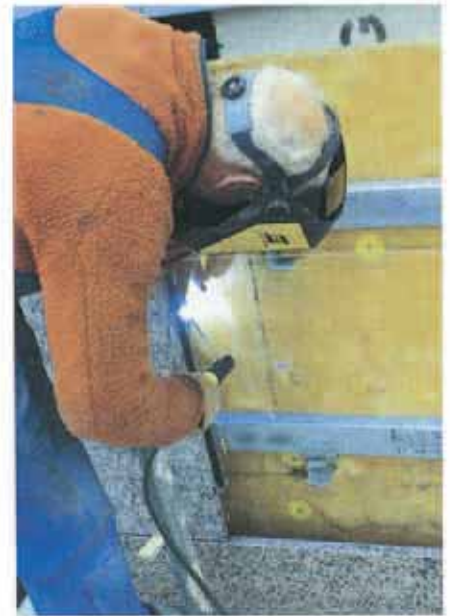
89. Svetsning av kramla mot bärverk.
