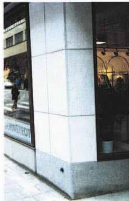
19. Maskintandhuggen marmorfasad. Sockel av flammad granit.
