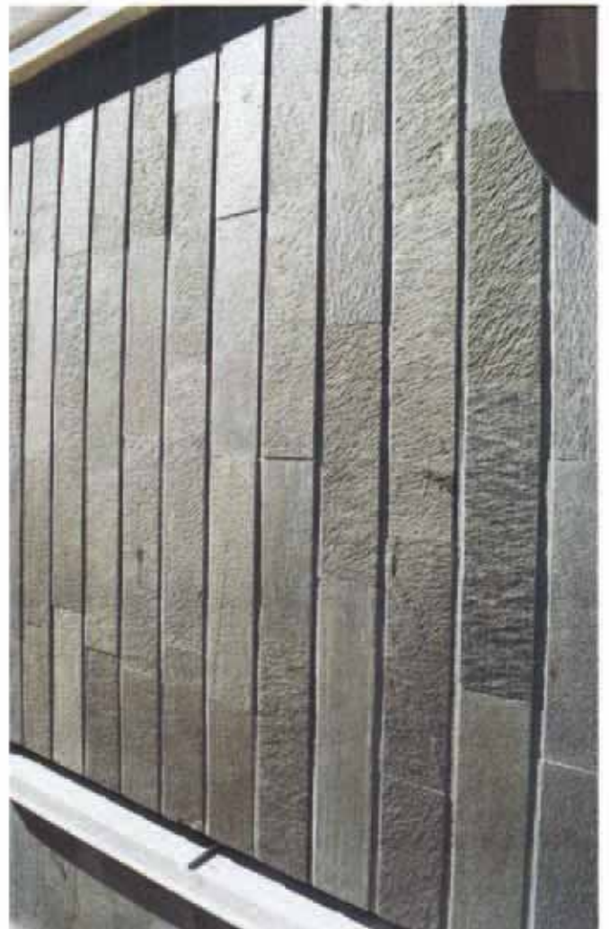
23. Smala remsor av skiffer med klovyta monterade i betong-element. Fogarna markeras genom nedfräsning av plattkanten.
