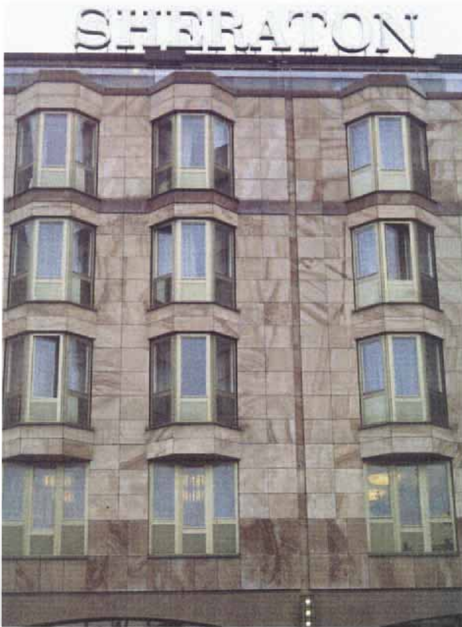
14. Älvdalskvartsit med krysshämrad yta. Fasaden är uppbyggd av prefab sandwich-element.
