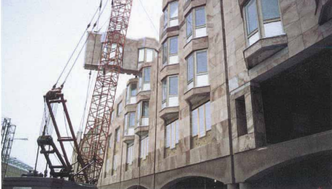
59. Montering av bärande betongelement typ 1:C, med fasadbeklädnad av kvartsit. Färdig byggnad, se sid 10.
