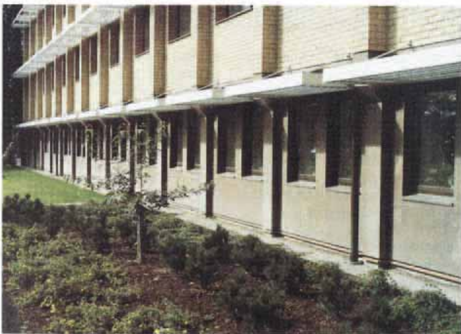
15. Finslipad, röd kalksten som bottenvåningsbegräddnad.
