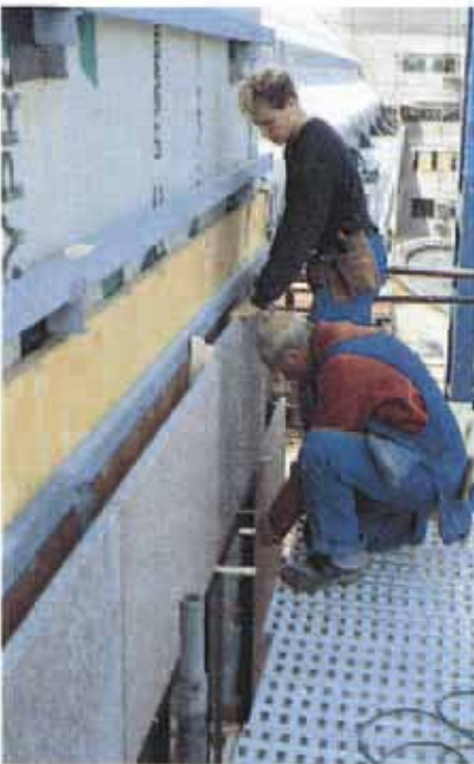
56. U-balk från byggnadens stomme utgör upplag för fyrkantrör, som svetsas fast. I detta fästs vertikalt L-stål med självborrande skruv. Stenen monteras med kramlor som svetsas mot L-stålet.
