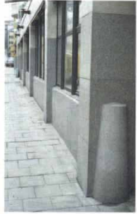
72. Pollare som integreras i sockeln utgör extra påkörningskydd vid exempelvis garageinfarter.
