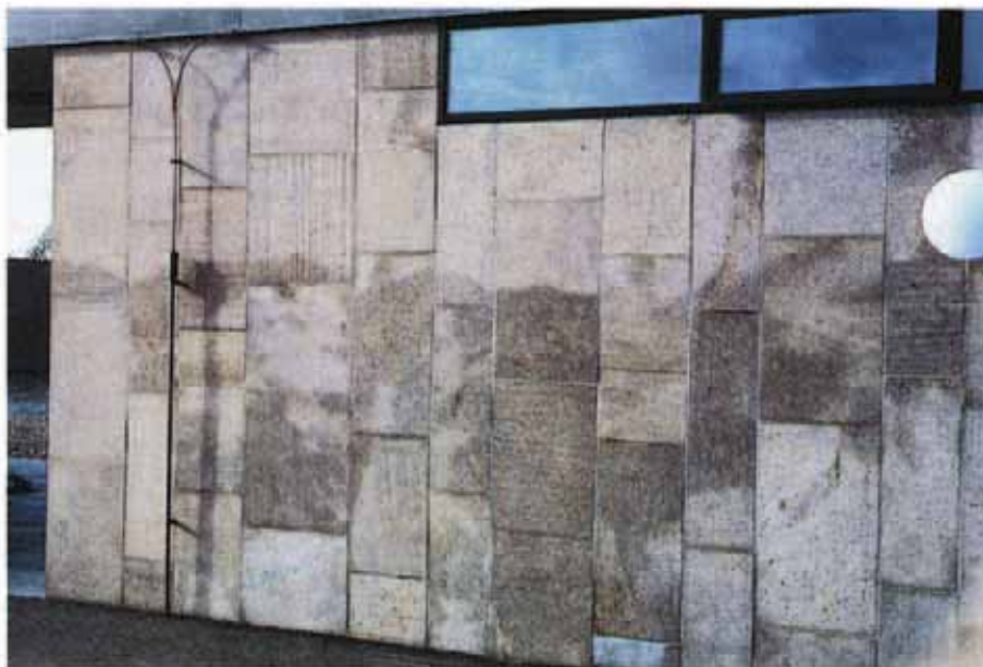
94. Bakgjutning med cementbruk kan orsaka misspyrdande fuktfläckar.
