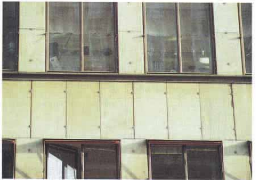
3. Tunna fasadplattor monterade i bruk och senare säkrade med genomgående infästningar med synliga brickor.
