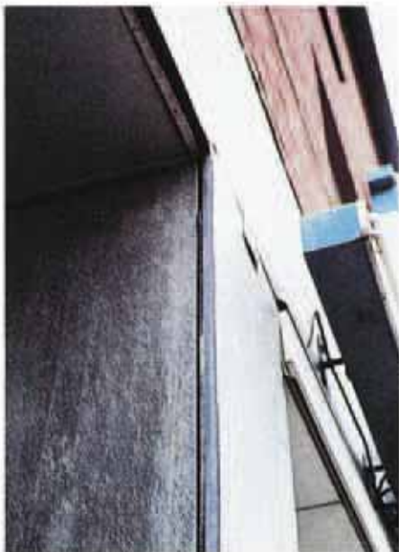
93. Beklädnad som utsätts för belastning från ovanliggande material trycks ut.
