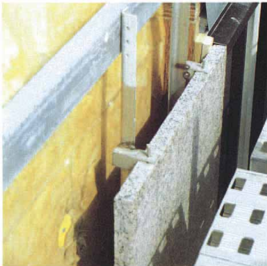
28. I anslutning till stenbeklädnaden kan många material förekomma, t ex stål för infästning, värmeisolering, plåt till avtäckningar, mm.
