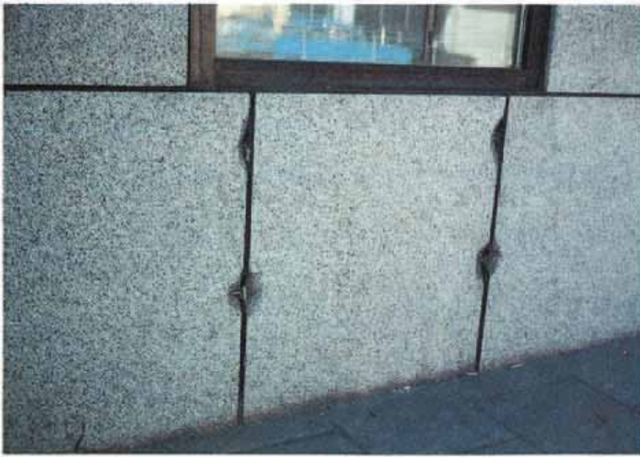
91. Om sockelplattor utsätts för alltför stort tryck kan dubbarna tryckas genom plattan.
