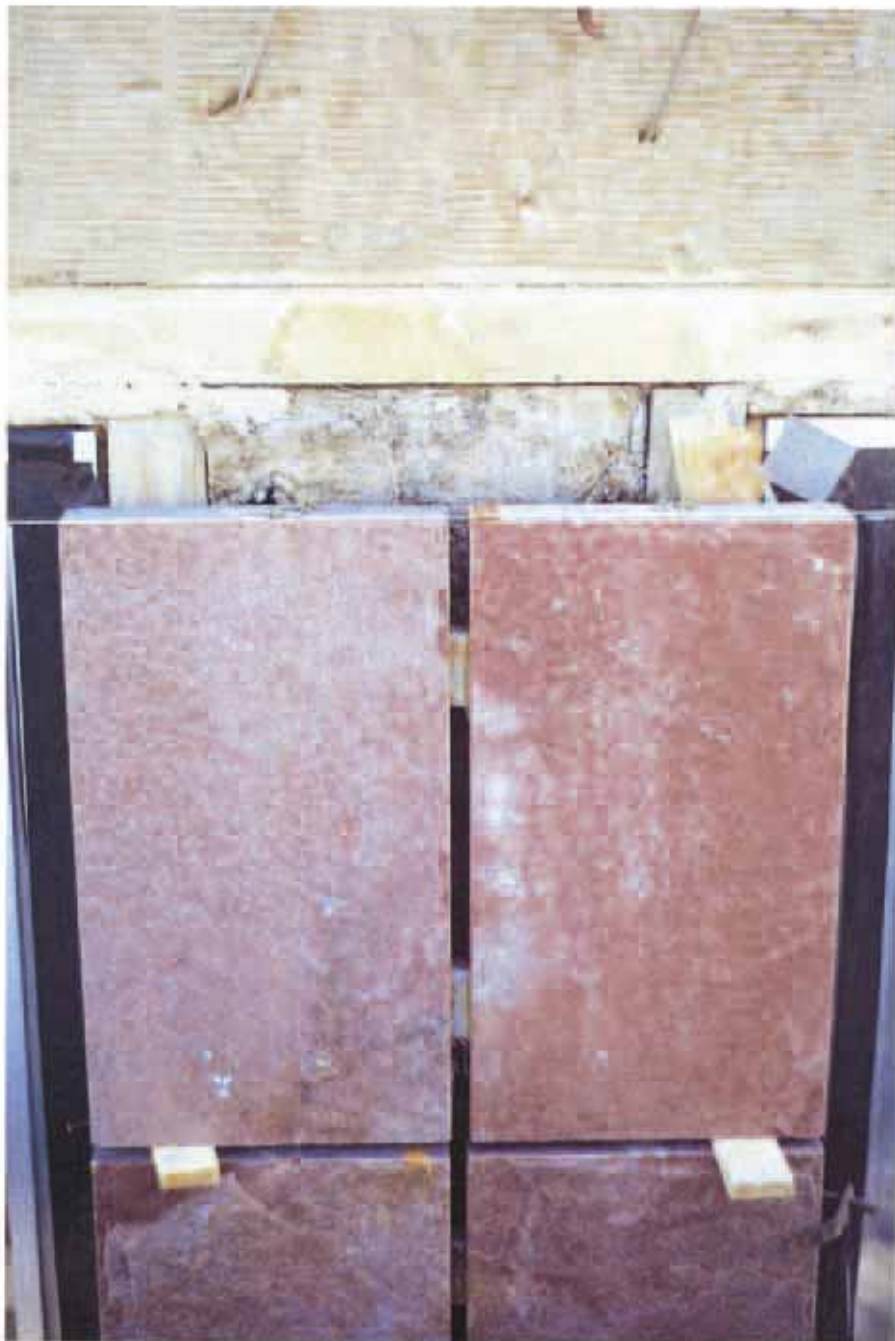
24. Små fasadplattor sammanfogade till element enligt nedanstående skiss. Beklädnaden fogades sedan med elastisk fogmassa.
