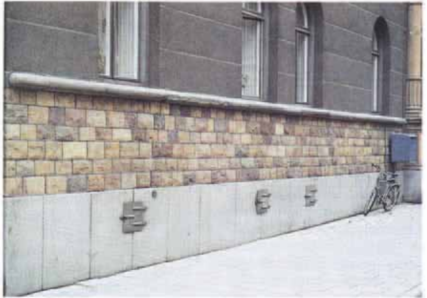
2. Fasadstenen murad som en integrerad del av byggnadens bärande stomme.
