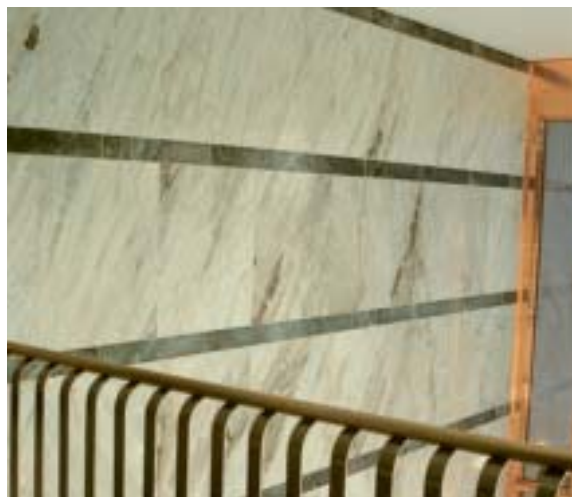
Fig 6.2 Exempel på väggmönster.
