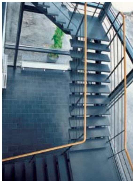
Fig 5.22 Trappa med fribärande steg på stålkonstruktion.
