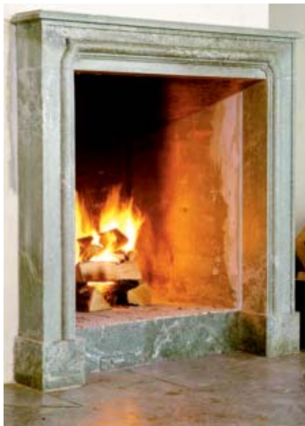
Fig 9.4 Profilerad omfattning av marmor.
