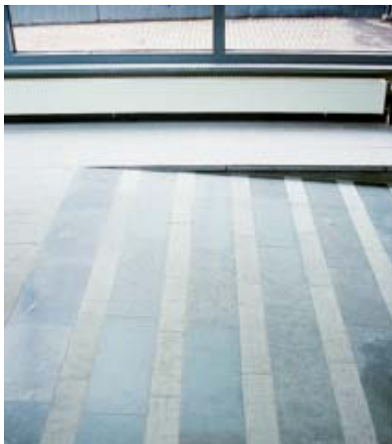
Fig 4.45 Lutande ramp av kalksten i kontorsentré. Läggerhuggna band utgör halkskydd och visuell markering.
