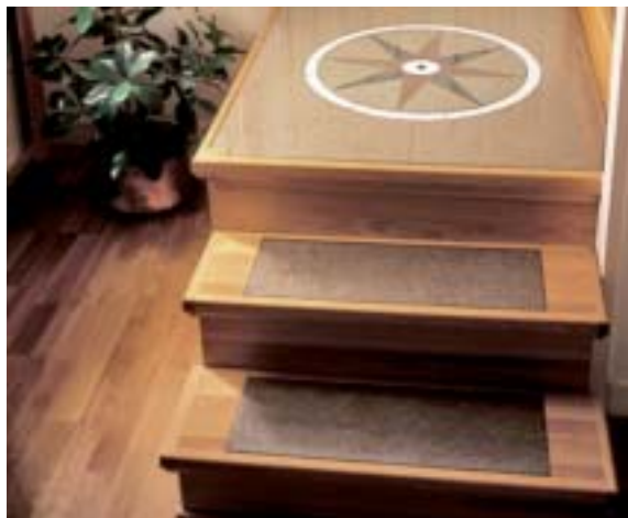
Fig 5.28 Trätrappa med kalksten infälld.
