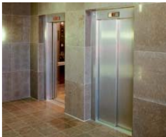
Fig 6.3 Hissomfattning av polerad kalksten.
