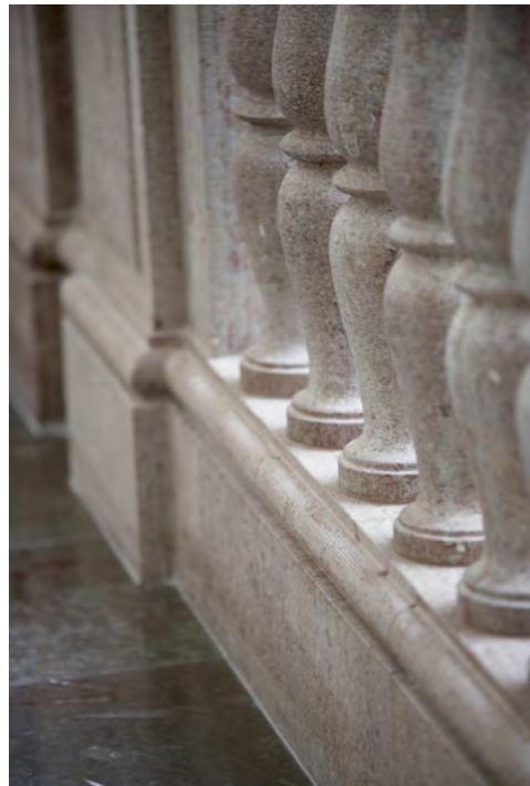
Tre olika bilder på en hantverksmässigt återskapad/rekonstruerad ballustrad av kalksten där överliggarens ovansida är slipad medan övriga ytor har tandhuggs.
