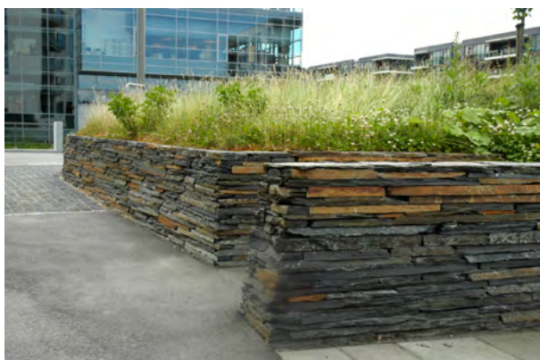
Kallmur av staplade skifferplattor med bräckt kant.
