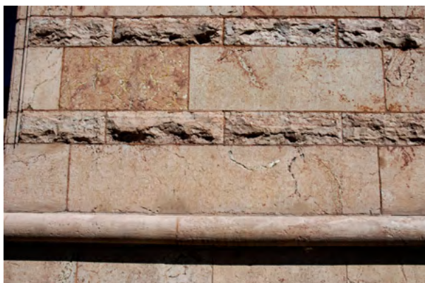
Lågerhuggen och dubbelstucken mursten, skrädhuggen list, kalksten, Strandvägen, Stockholm
