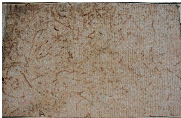
Tandhuggen kalksten i fasad, Strandvägen, Stockholm
