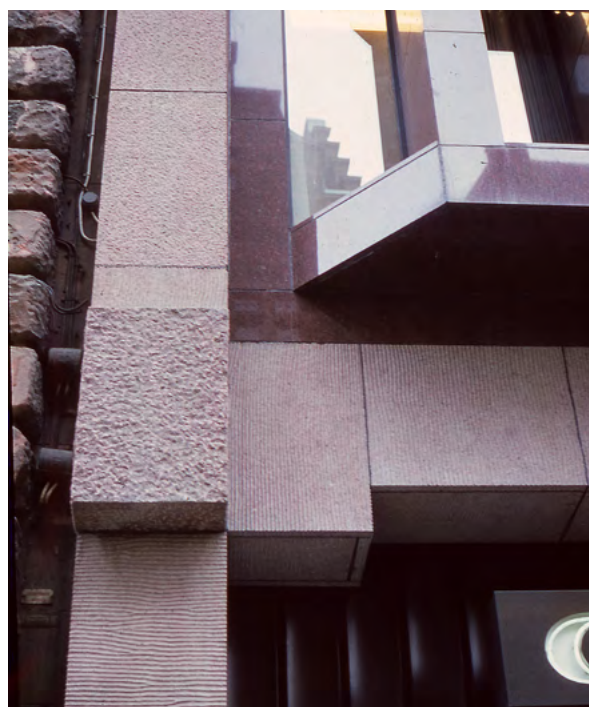
Polerad, krysshamrad, pikhuggen och randmejslad yta på samma röda granit ger kontrast i fasadbeklädnad.
