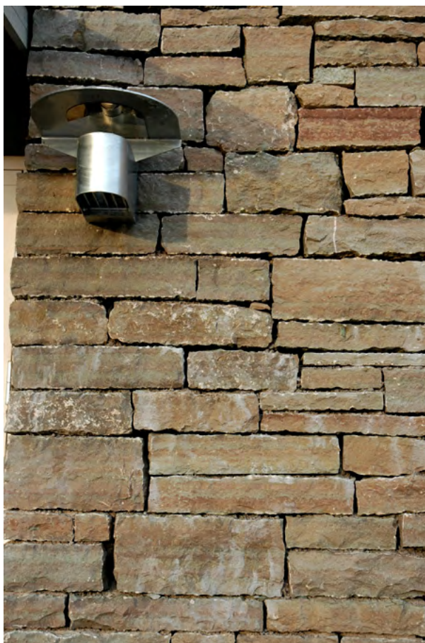
Fasad utförd som kallmur av klippt kalksten.
