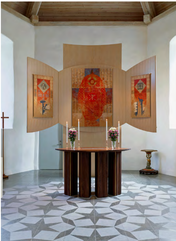
Mönster i golv skapat med olika ytbearbetningar, finslipning och blästring. En variant till att utföra mönsterläggning med olika plattor.
