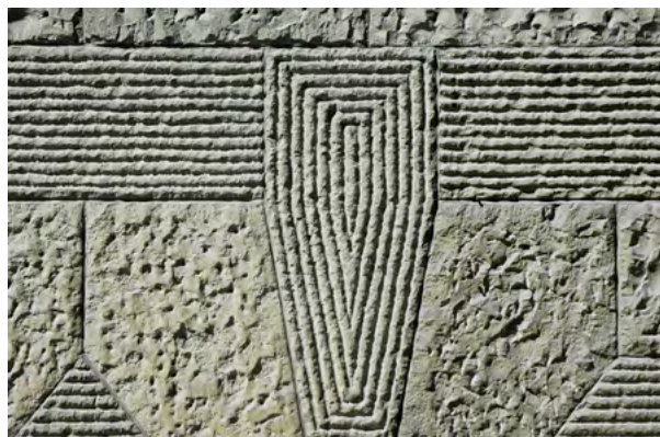
Sandstensfasad där mönsterhuggning ger speciell karaktär.
