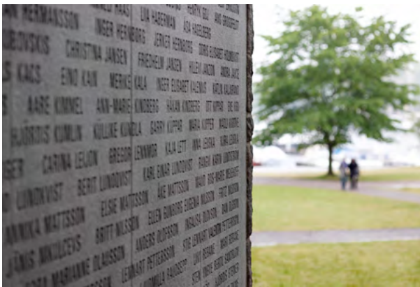
Skuggeffekten ger god läsbarhet av djupblästrad text i flammad yta på svart diabas.
