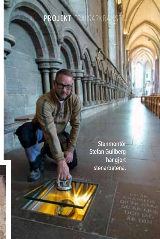
Stålkub på vilken stenplattor sedan monterats.
