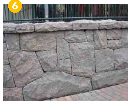
Kryssmur. Oregelbundna månghörningar.
