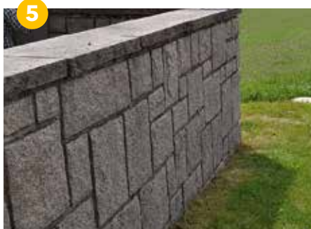
Rubbelmur. Rätvinkliga stenar i ojämna skift.
