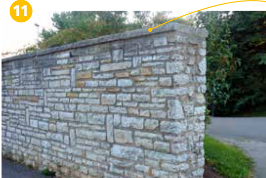
Bruksmuren måste ha täta avtäckningsplattor med täta fogar.
