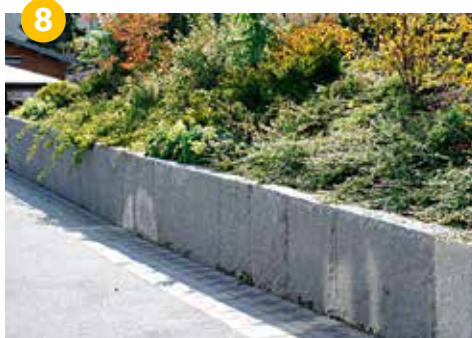
Blockstensmur (enskiftesmur). Hela rätvinkliga block eller skivor.
