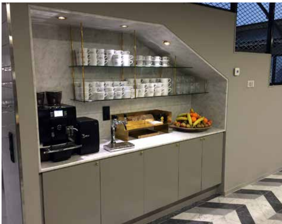
Detalj från projekt Primo i Billdal, signerat Pontus Lomar. Interiör runt en kaffestation, med skivor i Carrara C på både vägg och tak. Stengolv i fiskbensmönster. Arbetena är utförda av Kungälv's Natursten.
