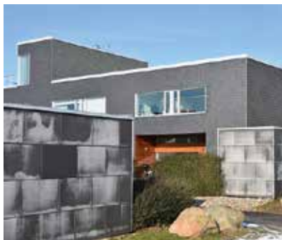
Fibercement som benämns "skiffer".
