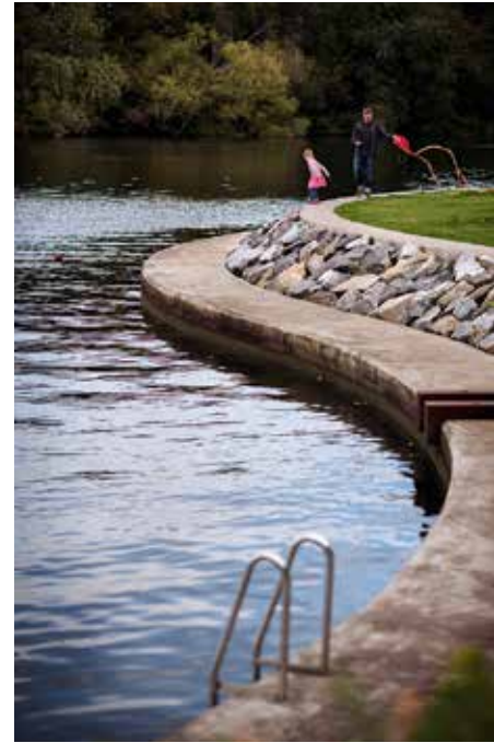
Årstidernas park i Umeå. Stödmuren byggdes av gammal kajsten, som legat mer eller mindre bortglömd i skogen sedan 80-talet.
