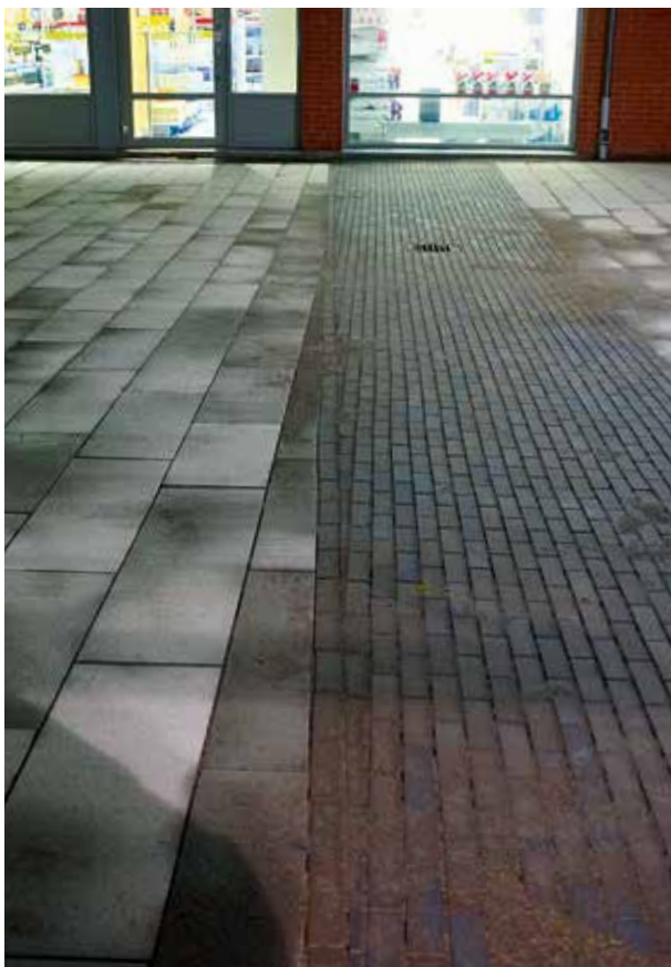
◀ Hällar i Bjärlövsgranit. Liggförband med en halv stens förskjutning, 1 050 x 350 millimeter.
