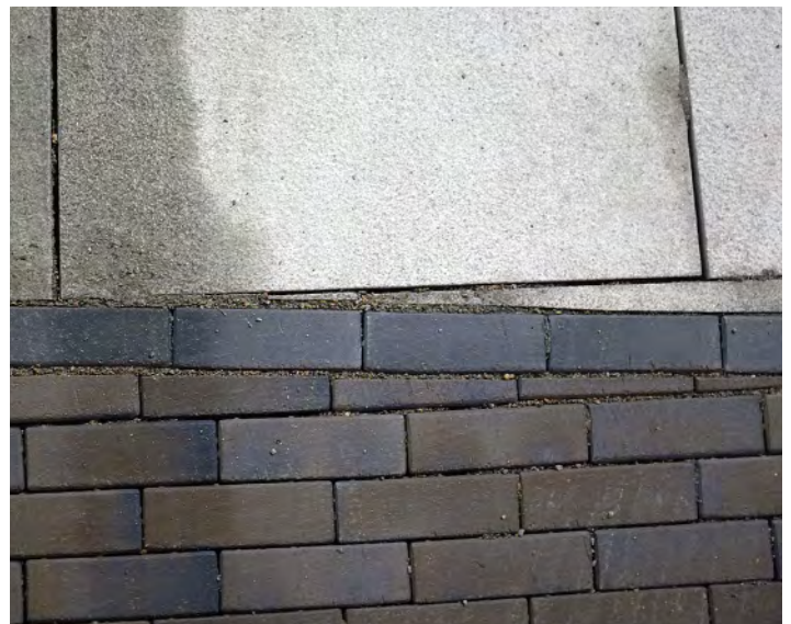
Beläggningen varvar Höganästegel i olika röda nyanser med grå granit.
