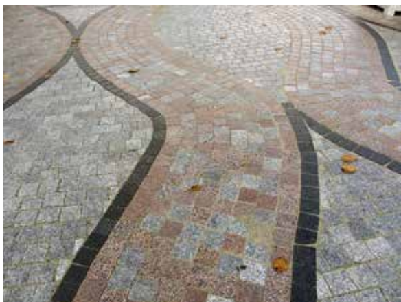
Flammad smågatsten har lagts i böljande mönster på Fisktorget.
