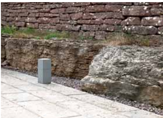
Gångarna består av normalhyvlade kalkstensflisor.
